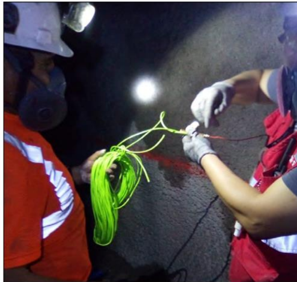
Figura 36. Control del empalme a la mecha
