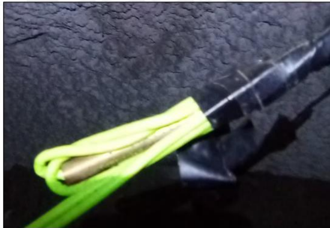
Figura 35. Empalme de la cápsula a la red pirotécnica
