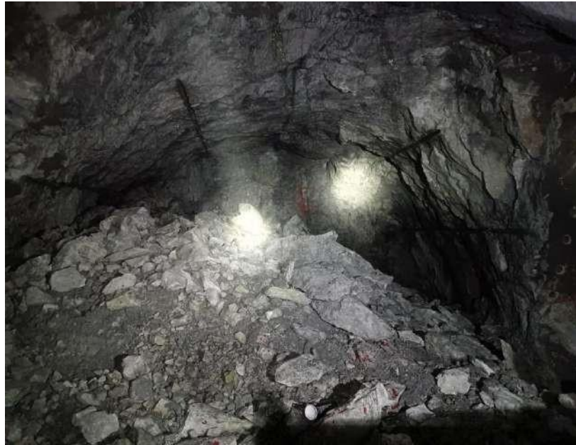
Figura 20. Se evidencia el resultado de la voladura en la GAL_253SW NV.20 Sección Cuerpos.
