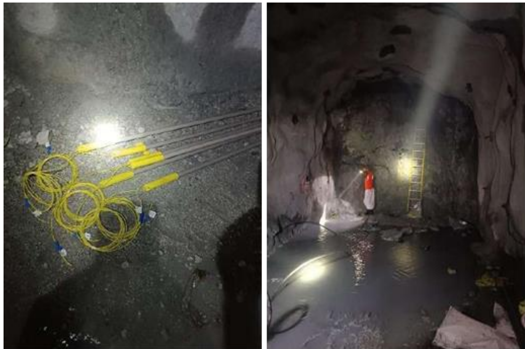
Figura 19. Se evidencia la preparación de las cañas con ANFO a granel en tubería PVC \frac{3}{4} y el proceso de carguío en la GAL_253SW NV.20 Sección Cuerpos.
