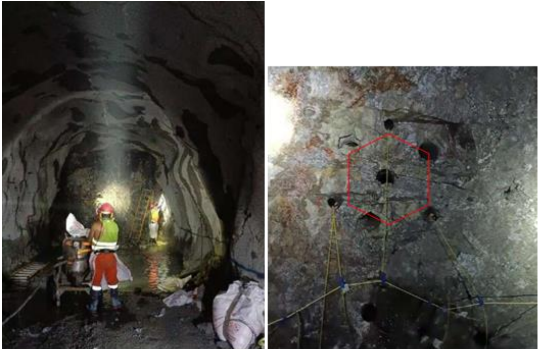
Figura 8. Se evidencia el proceso de carguío y falta de simetría en los taladros del arranque en la GAL_261N NV. 19A Sección Cuerpos.
