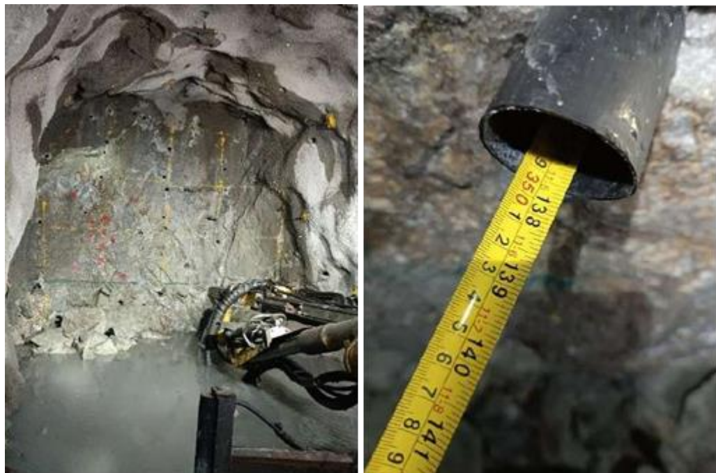
Figura 7. Se evidencia el proceso de perforación y la longitud de perforación de 3.7m en la GAL_261N NV. 19A Sección Cuerpos.
