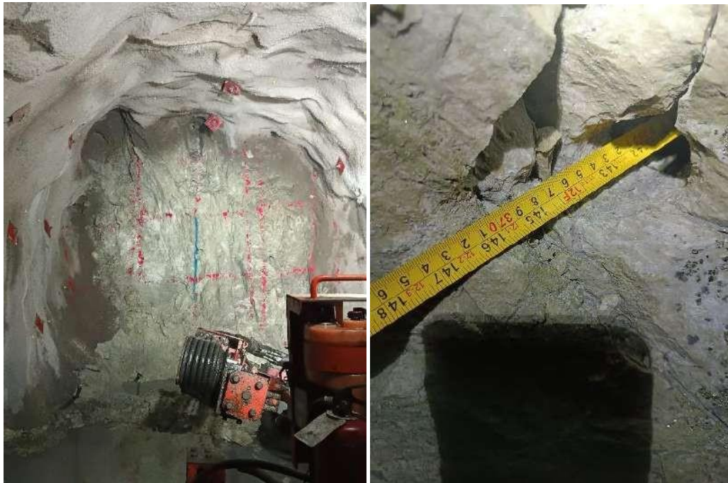
Figura 12. Se evidencia el proceso de perforación y la longitud de perforación de 3.7m en la GAL-400 NV.21 Sección Cuerpos.
