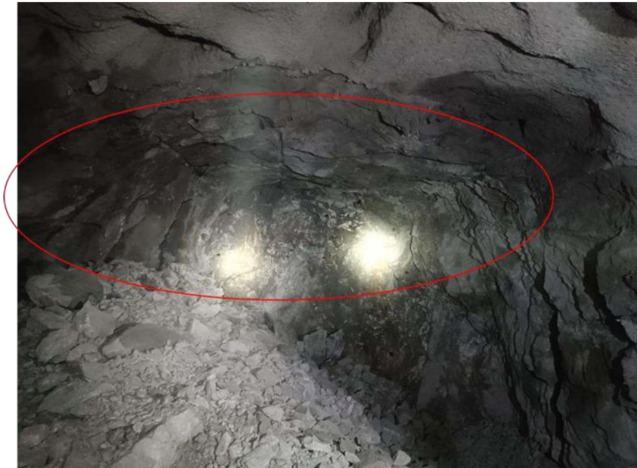
Figura 10. Se evidencia el resultado de la voladura con las medias cañas en el techo de la labor en la GAL_261N NV. 19A Sección Cuerpos.
