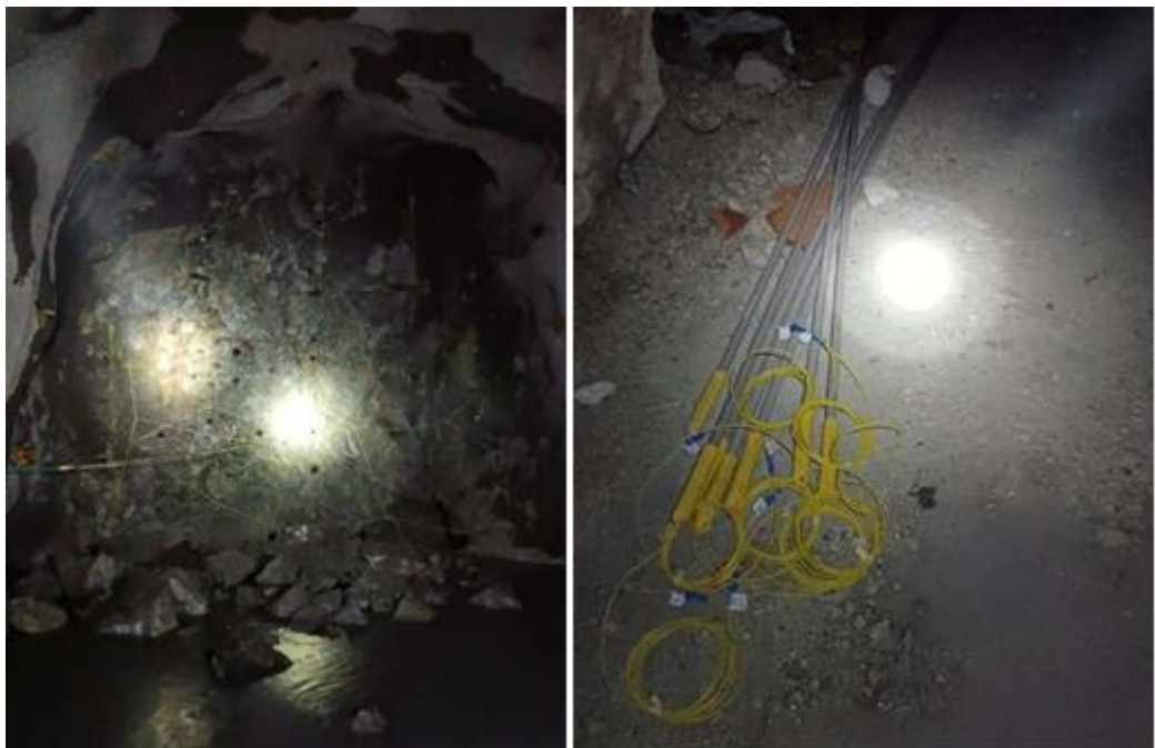
Figura 9. Se evidencia el amarre del Fanel LP y la preparación de las cañas con ANFO a granel en tubería PVC ¾" en la GAL_261N NV. 19A Sección Cuerpos.
