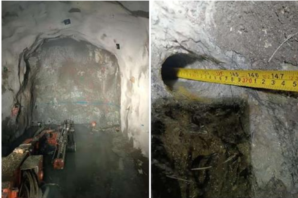
Figura 18. Se evidencia el proceso de perforación y la longitud de perforación de 3.7m en la GAL_253SW NV. 20 Sección Cuerpos.
