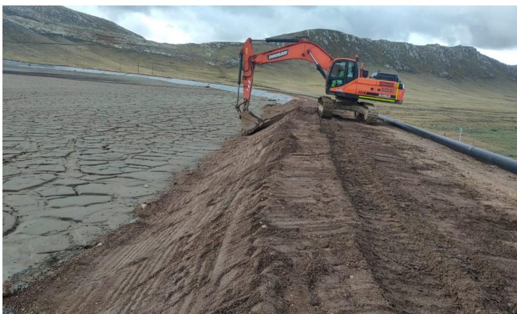
Imagen 27. Conformación de pantalla de protección al talud existente, tipo B
