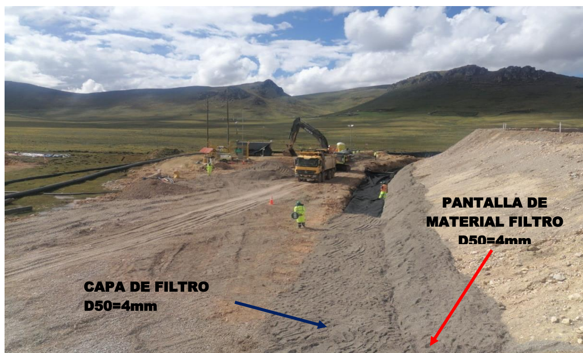
Imagen 21. Vista planta del sub-drenaje aguas de contacto
