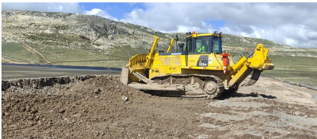
Imagen 32. Conformación de material tipo A con Bulldozer D8
