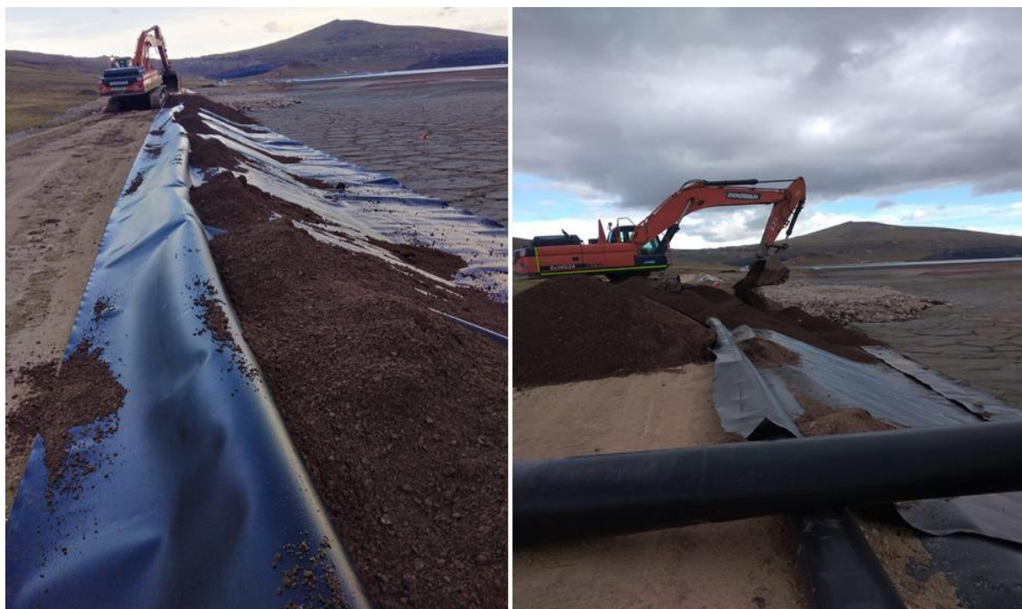
Imagen 26. Habilitación e instalación de geomembrana 1.5 mm protección de Dique
