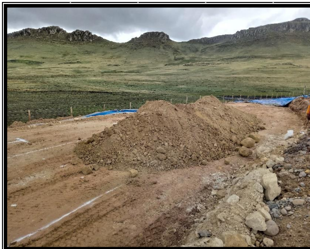
Imagen 25. Procedimiento de ejecución para el Panel Test
