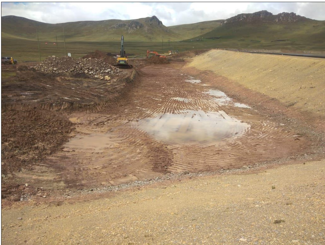
Eliminación de material incompetente para mejoramiento de fundación y canalización de aguas de contacto.
