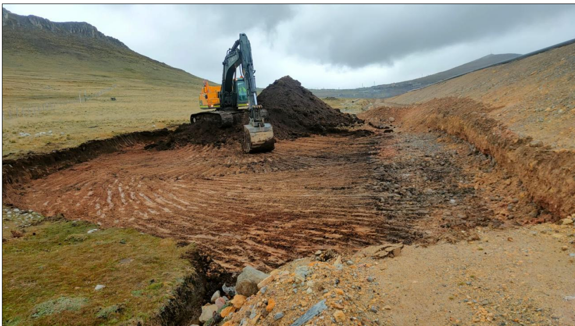
Desbroce del topsoil para conformación de canales de derivación de aguas de contacto.
