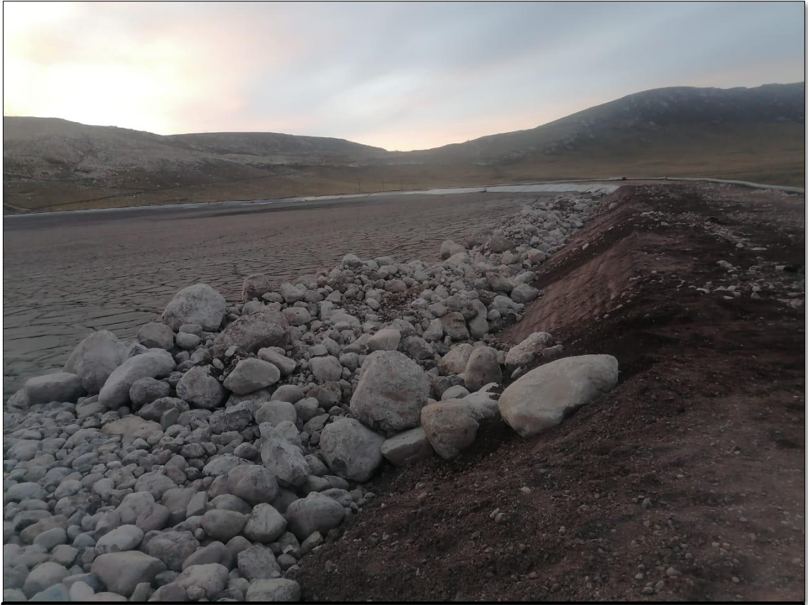
Mejoramiento de fundación de relaves con material tipo E
