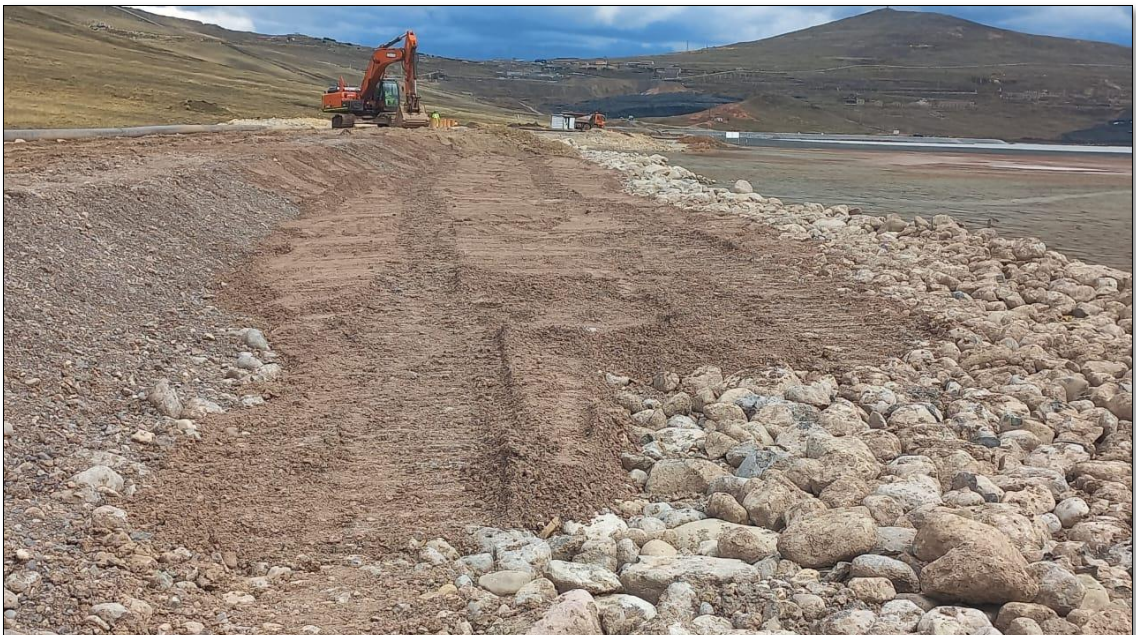
Conformación de material enrocado Tipo E, relleno de espacios vacíos con material tipo B
