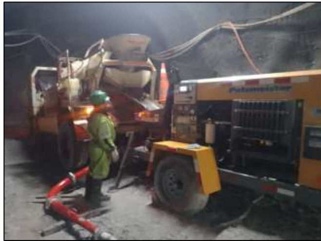
Ilustración 16. Trasegado de concreto hacia la bomba TK20
