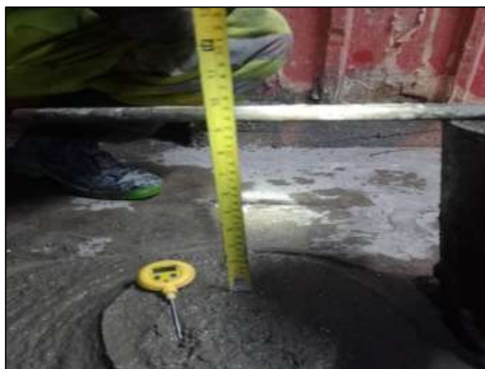
Ilustración 15. Medición de slump - shotcrete
