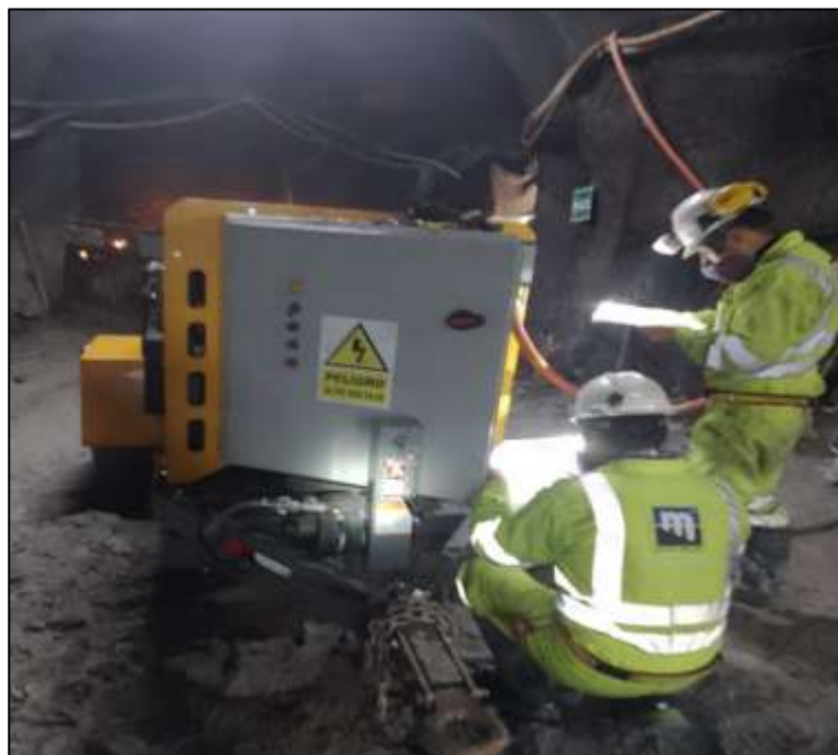
Ilustración 14. Inspección de Bomba de Concreto
