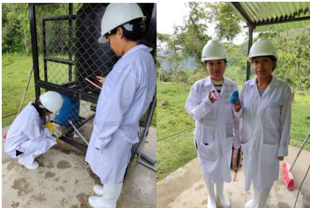
Fotografía 13. Calibración de dotación de Cloro
