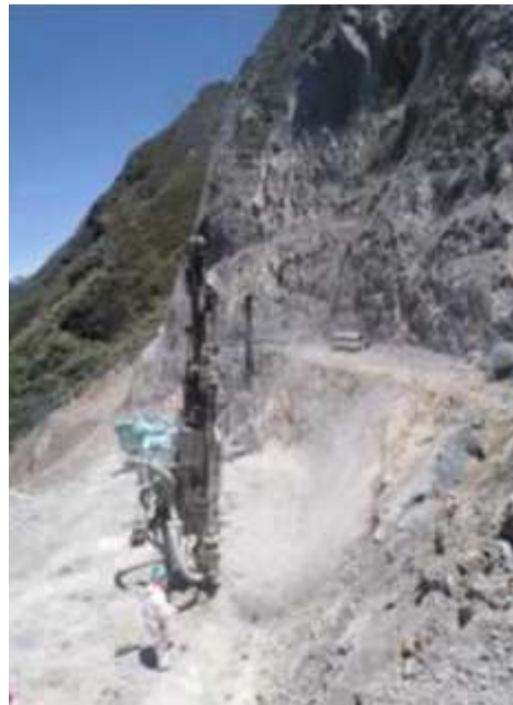
Figura 30. Perforación con Rock Drill, Frente 3 (0+475 a 0+505)
