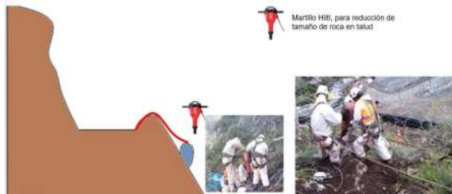
Figura 23. Limpieza de taludes con rapel
