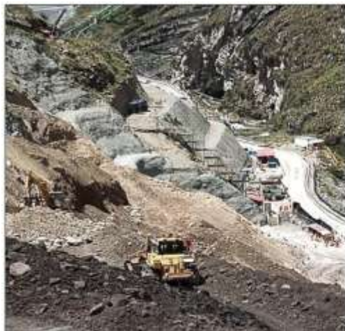
Figura 18. Ejecución de la berma a lo largo del acceso
