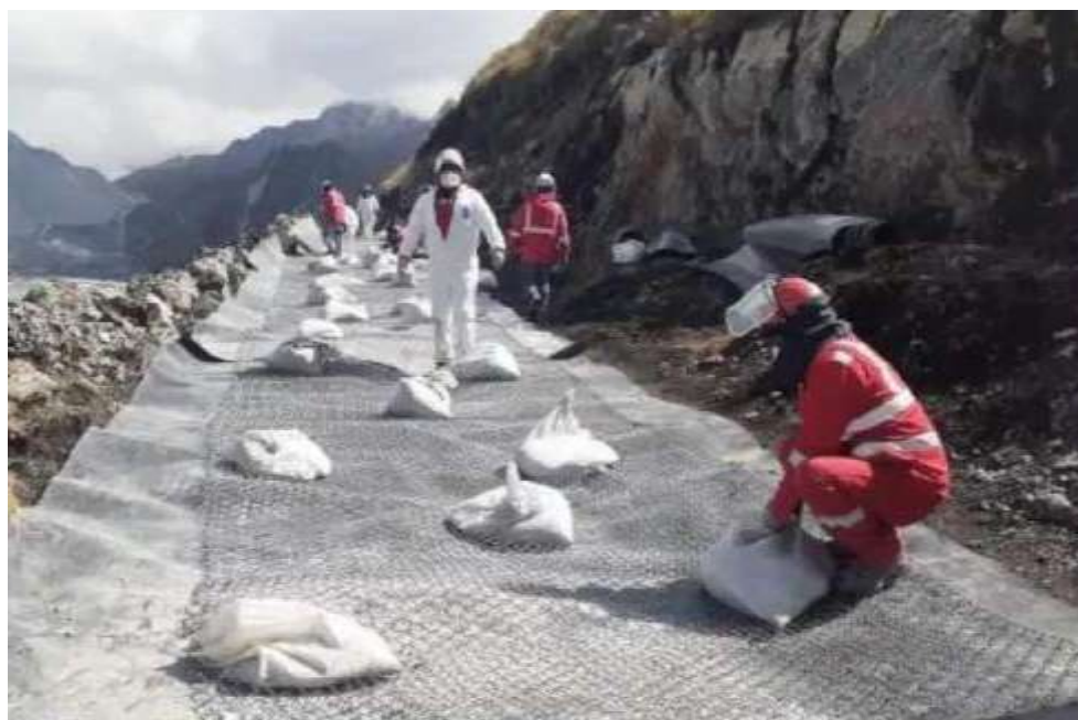
Figura 55. Recubrimiento de taladros con geomembrana, malla y sacos de stemming
