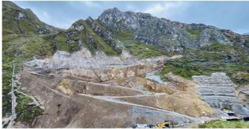
Figura 17. Operaciones superficiales en el pórtico del túnel
