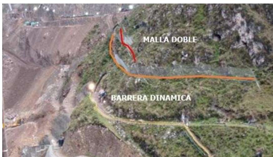
Figura 25. Barrera dinámica y malla de doble torsión
