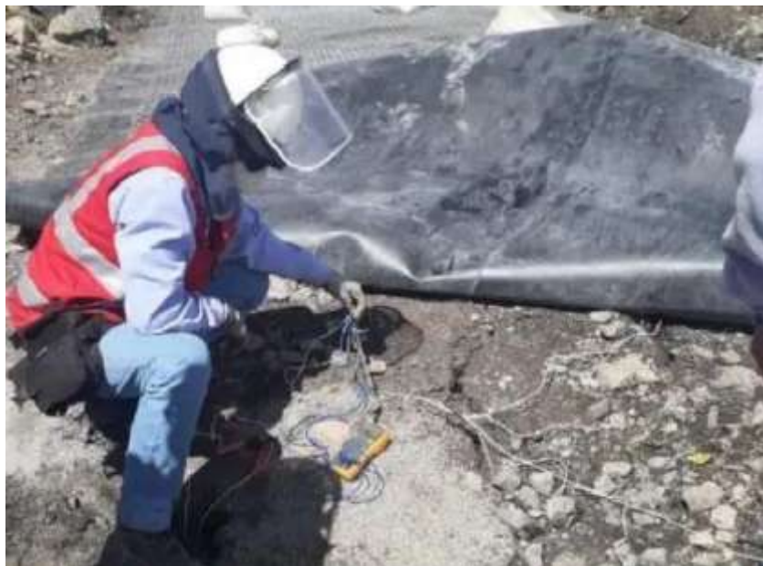
Figura 58. Comprobación de taladros detonados
