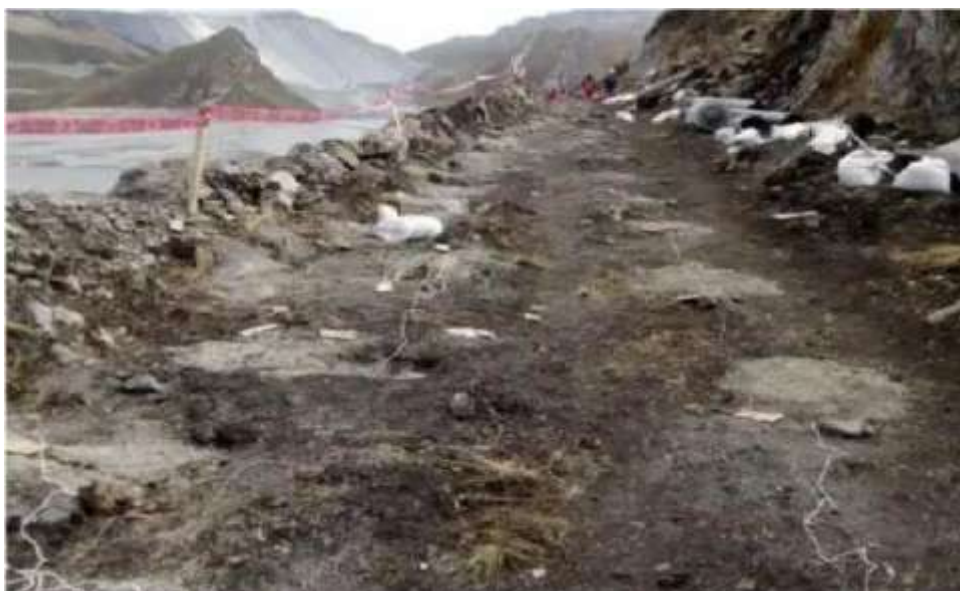
Figura 54. Sujeción de la malla a fragmentar
