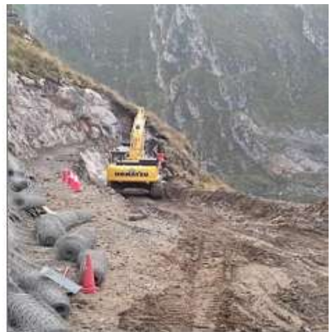
Figura 18. Ejecución de la berma a lo largo del acceso
