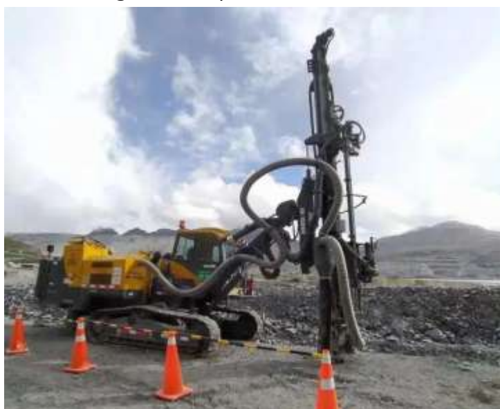
Figura 2. Perforadora Rock Drill
