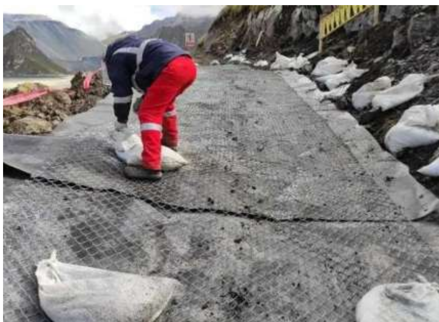
Figura 10. Protector de la malla mediante geomembranas
