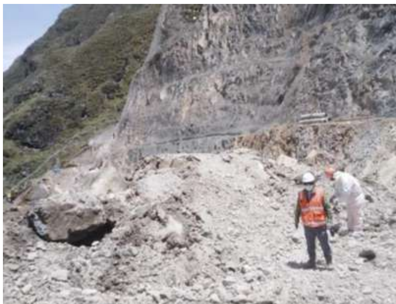
Figura 46. Fragmentación de manera regular
