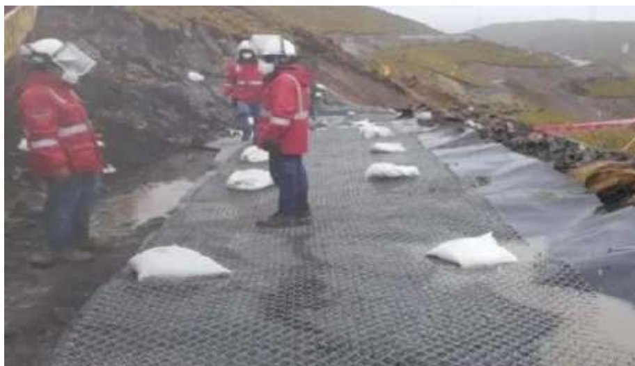
Figura 61. Recubrimiento de taladros con geomembrana, malla y sacos de stemming
