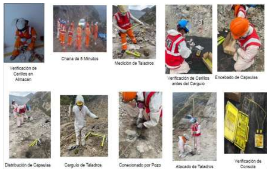
Figura 13. El procedimiento de carga de los taladros
