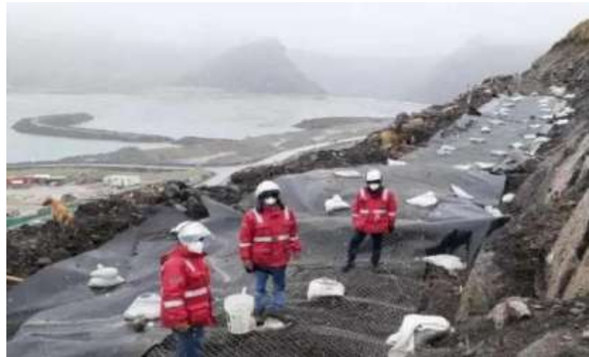
Figura 65. Verificación de taladros detonados
