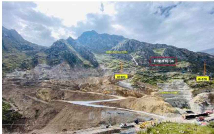
Figura 12. Área de labor frente 04 y túnel
