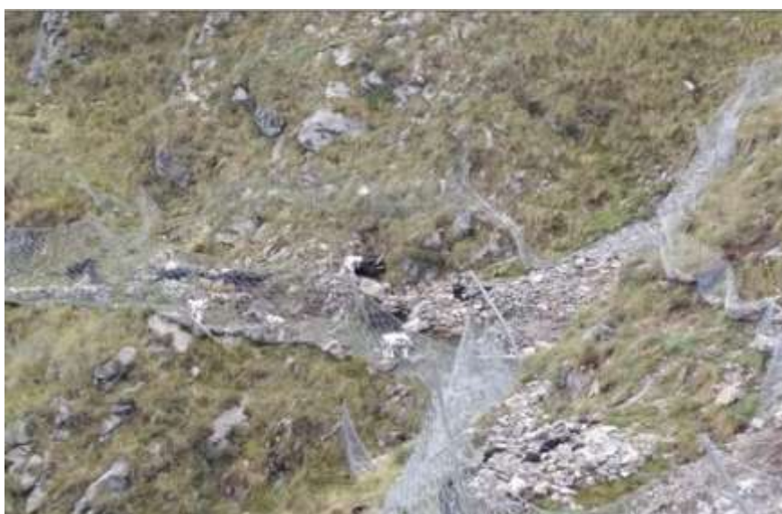
Figura 26. Descolmatación de las barreras dinámicas
