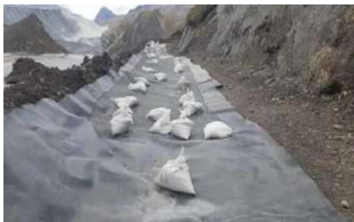
Figura 47. Protector de taladros con geomembrana, malla y bolsas de vaporización
