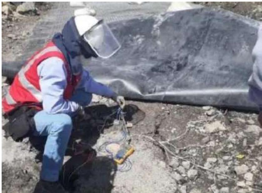
Figura 58. Comprobación de taladros detonados
