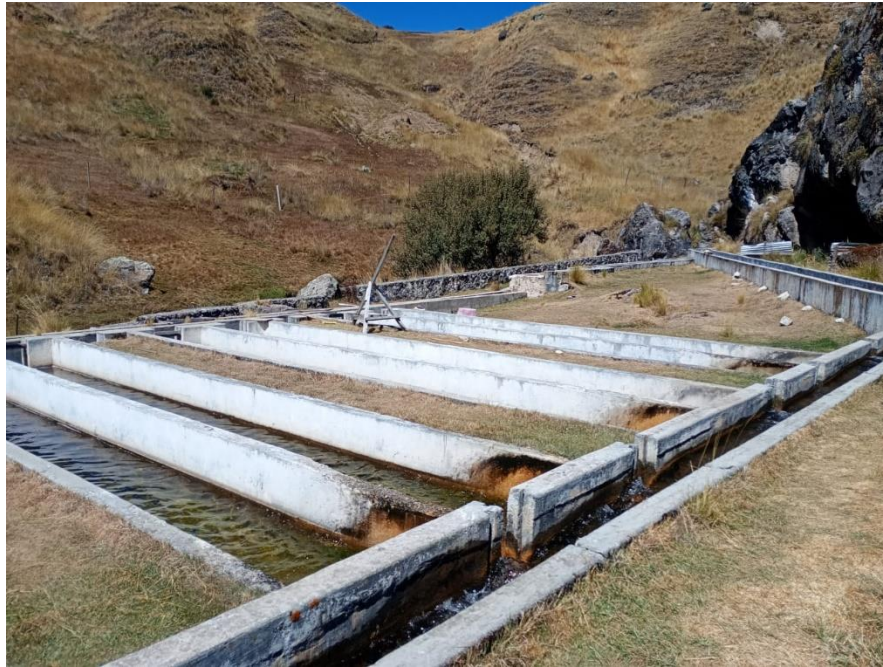
Figura 8. Infraestructura que cuentan los productores de trucha Arco Iris en el Centro Poblado de Antamachay
