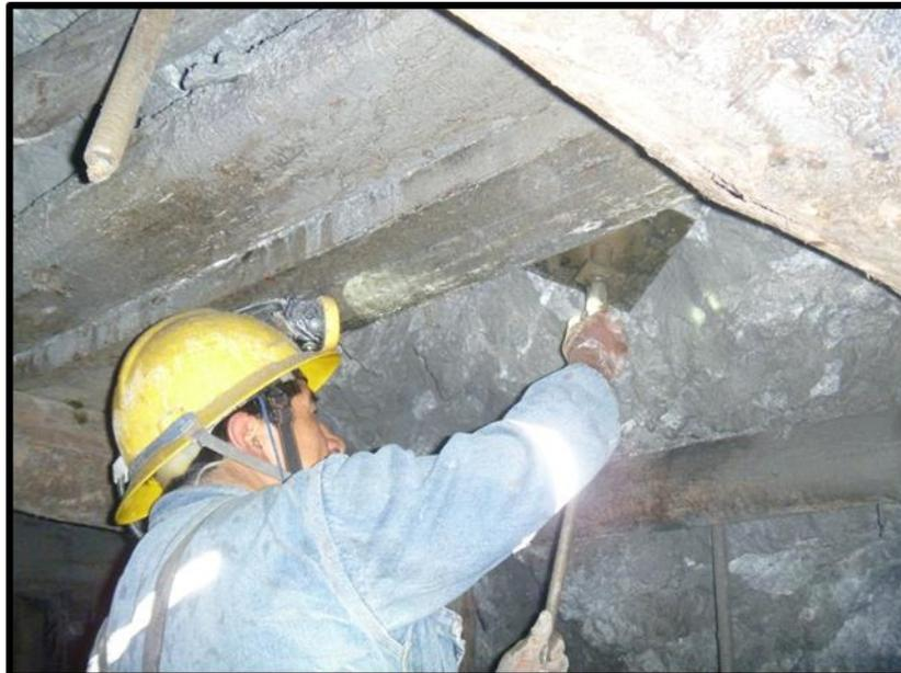
Foto N° 5.2: Instalación del Hydrabolt.
