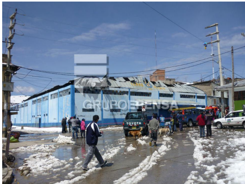
Ilustración 6 Colapso del coliseo de Chaupimarca
