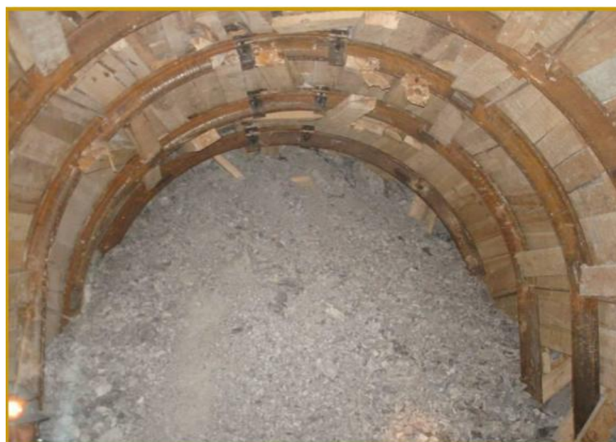
Figura 4 Sostenimiento con cimbras deslizantes
