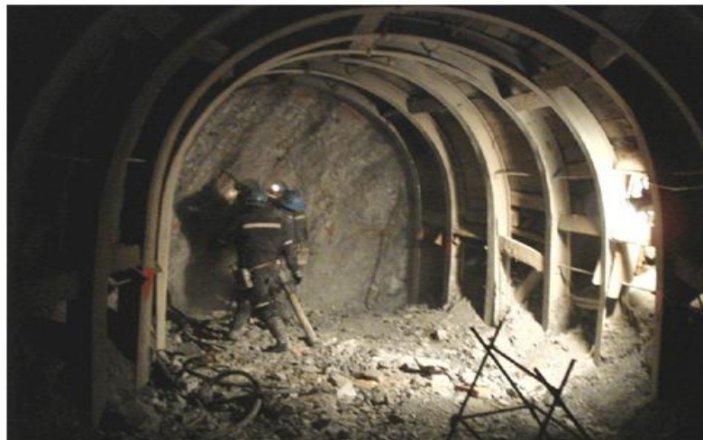
Figura 30. Labor sostenimiento con cimbras rígidas
