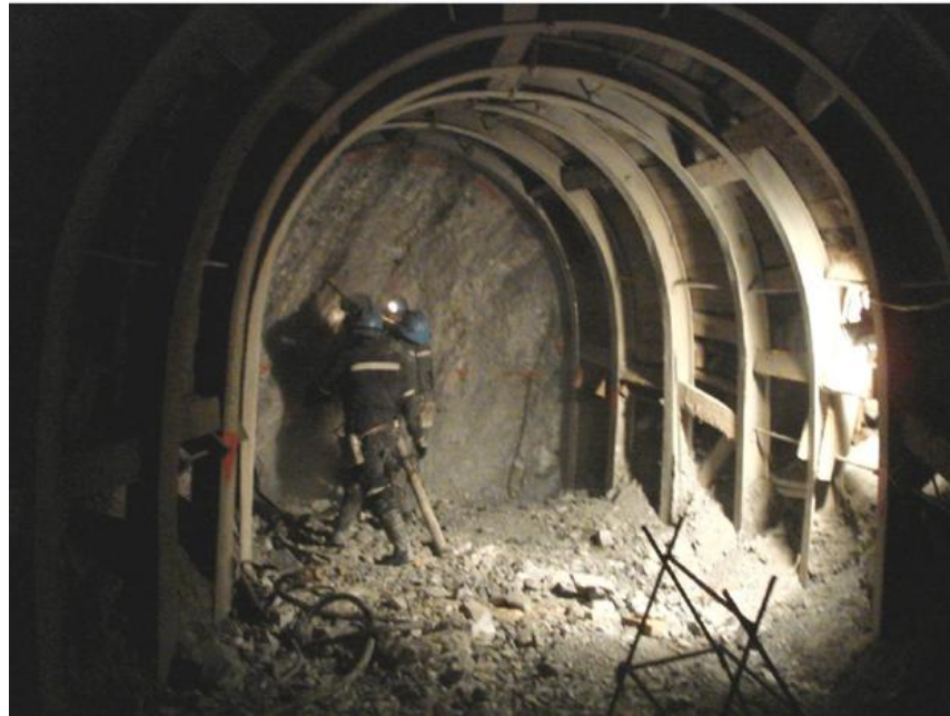
Figura 2 Sostenimiento con cimbras rígidas
