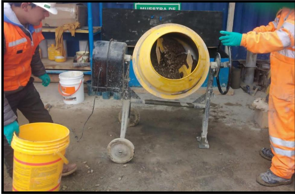
*Fotografía 07.- Mezclado de materiales en el trompo respetando el tiempo según norma.*
