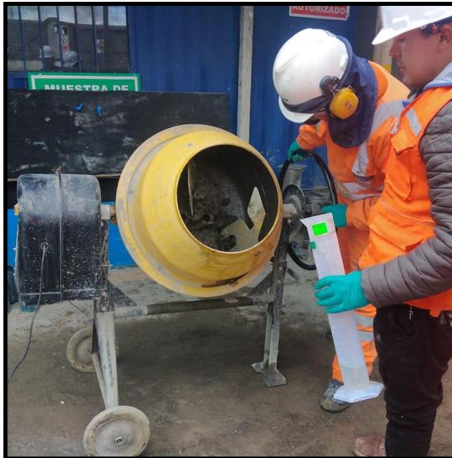
*Fotografía 08.- Adición de aditivos durante el mezclado.*
