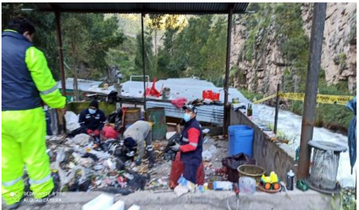
Foto 13. Segregación de los residuos sólidos
