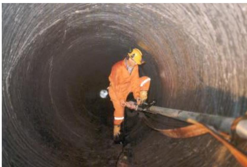
**Imagen N° 13: Chimenea por el método Raise Borer**
