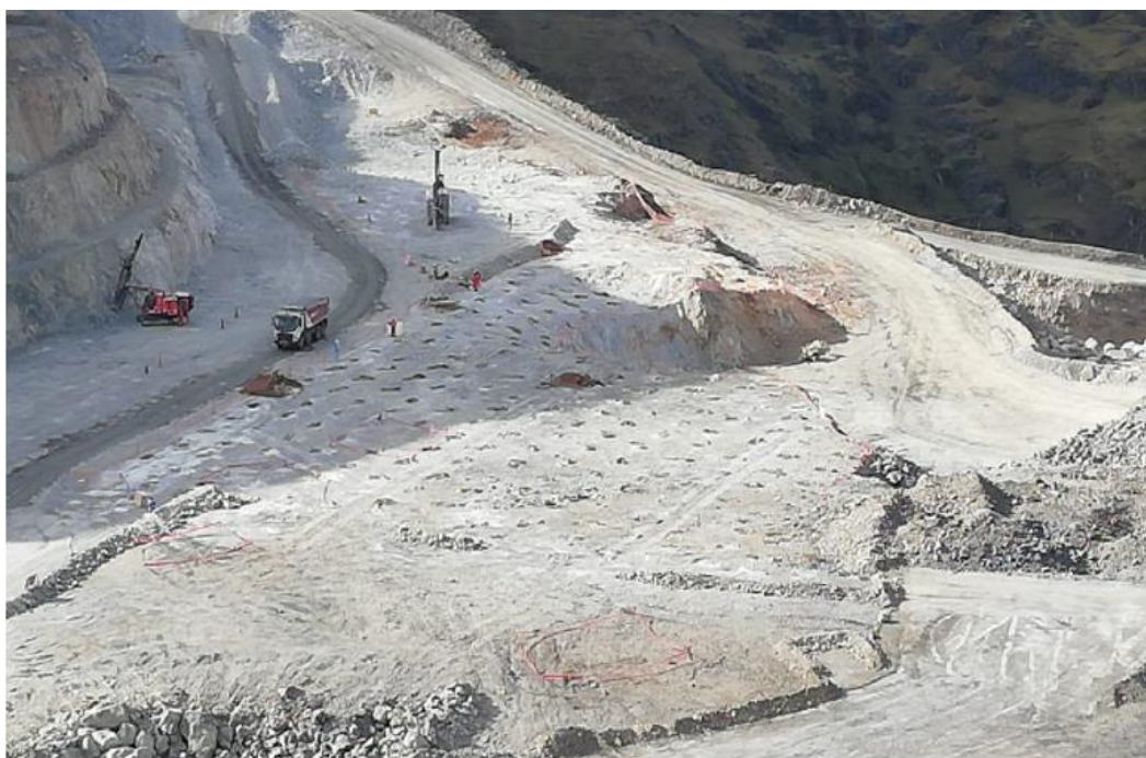
Figura 20 Taladros perforados en el Tajo San Gerardo
