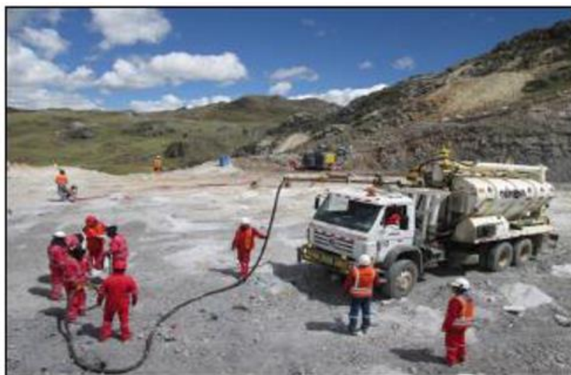
Figura 32 Carguío de los taladros para la voladura
