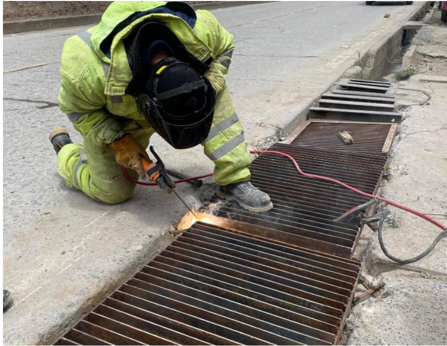
Ilustración 3: Instalación de sistema de drenaje (Av. Minero)
