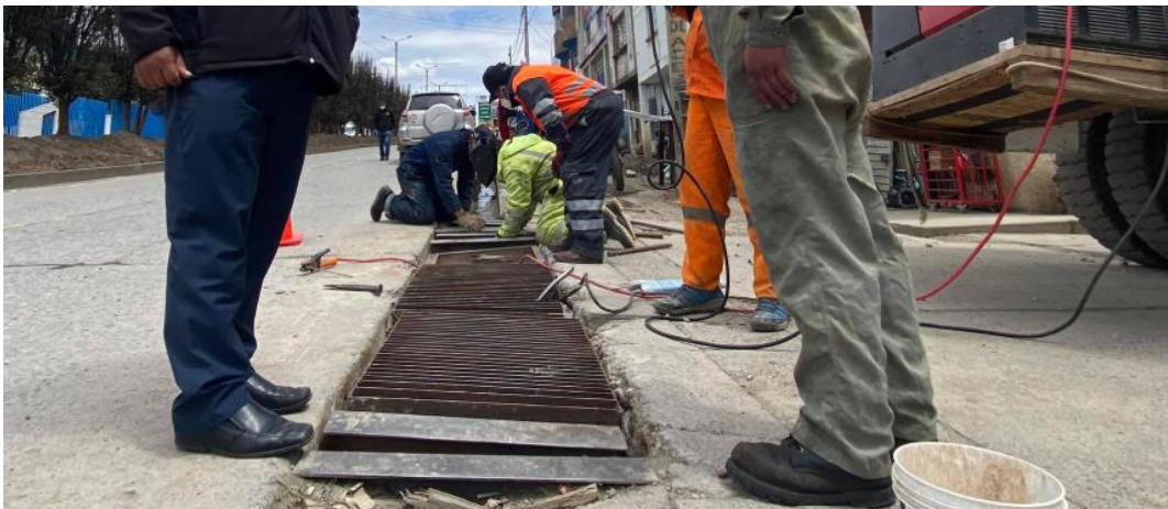
Ilustración 2: Verificación del sistema de drenaje en Av. Minero (Cerca a Av. Proceres)
