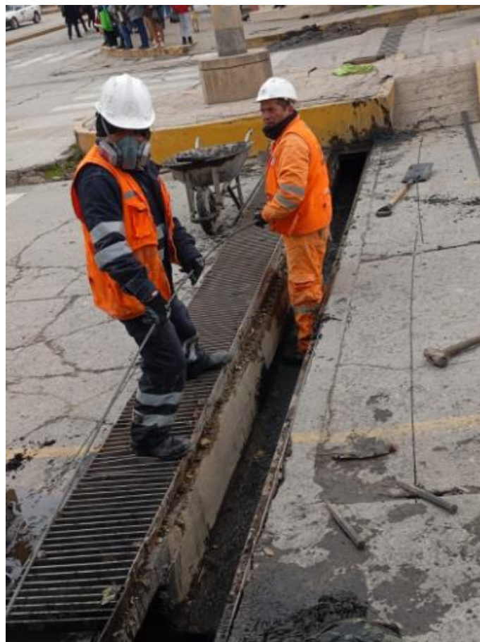
Ilustración 3: Instalación de sistema de drenaje (Av. Minero)
