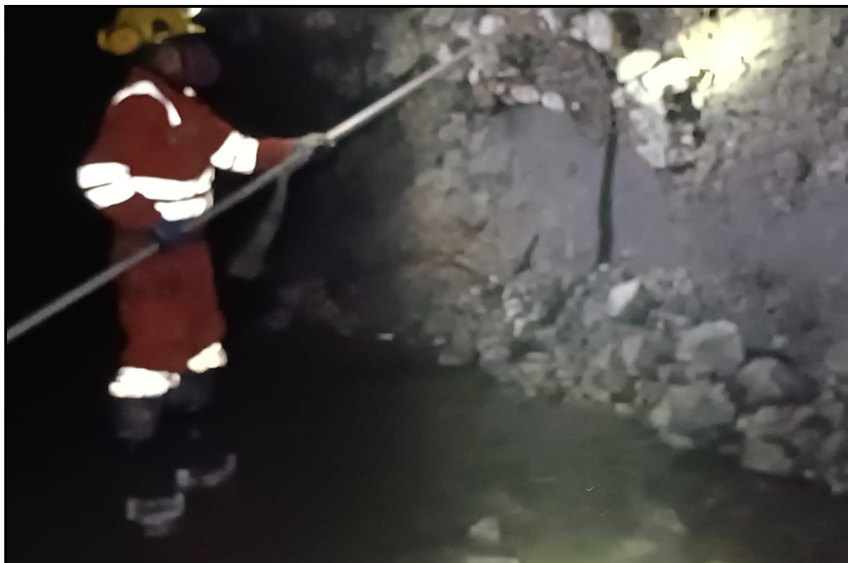
Fotografía N° 005: Vista de las actividades de desate
