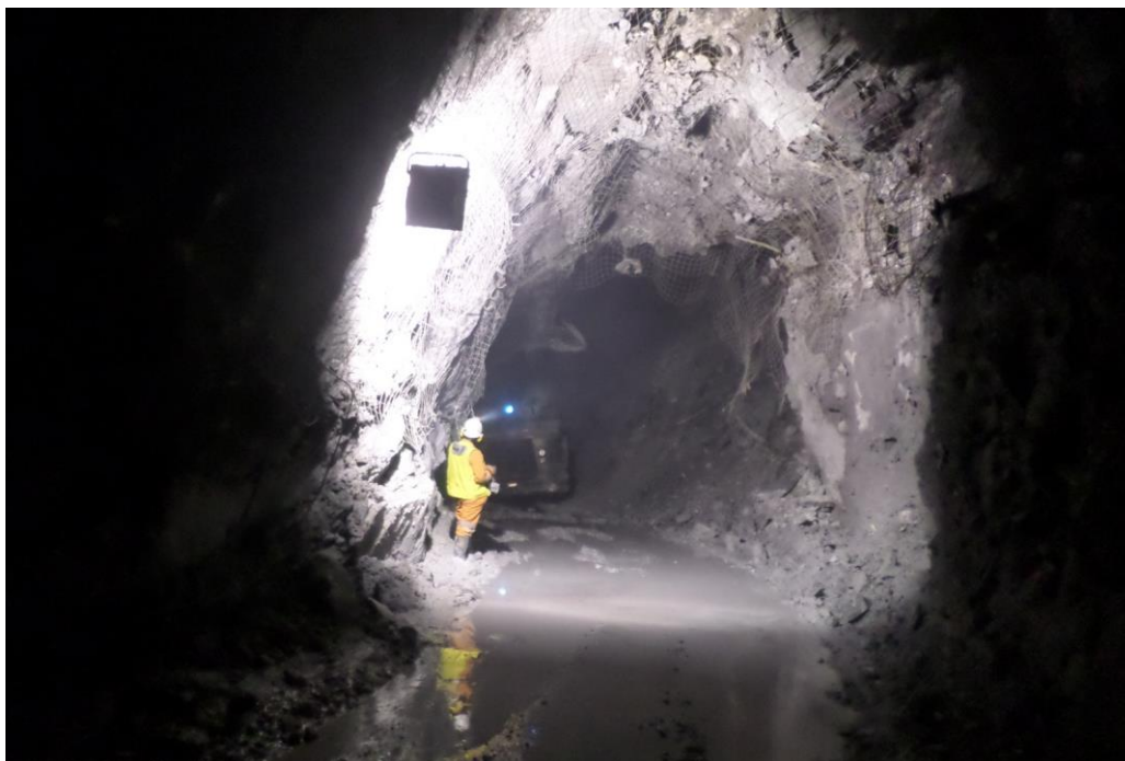
Imagen 2 Vista del acceso de sección 3.5 m x 4.0 m
