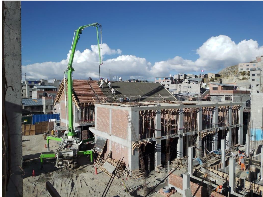
Ilustración 1: Bombeo de concreto – Planificación por Sectores
