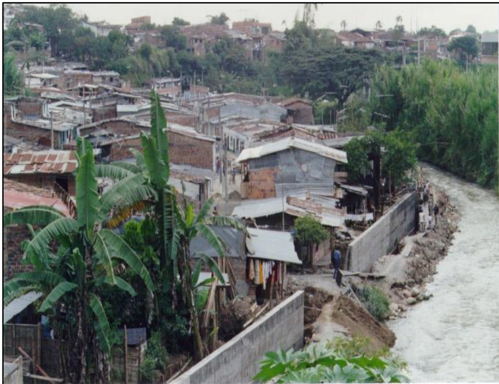
Figura 1: Defensa Ribereña en construcción
