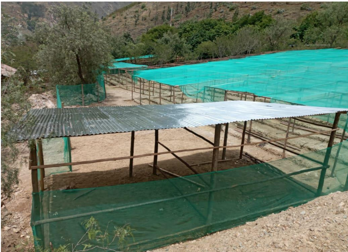
Instalación del vivero
