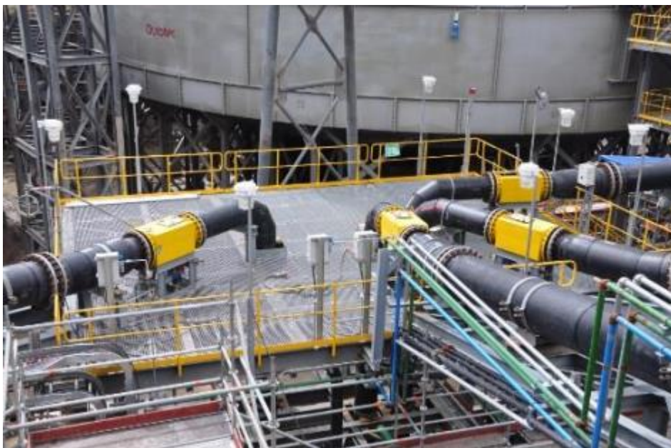
Fotografía 2. Flujo de canaletas de concentrado rougher a cajón de celdas cleaner
