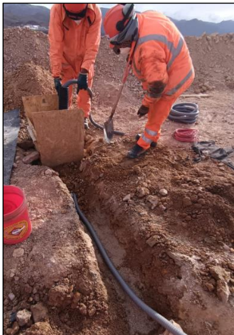
ING/PCV-PU21-022 encofrado y protegido para su automatización
