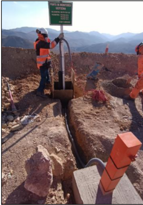
ING/PCV-PU21-021 encofrado y protegido para su automatización
