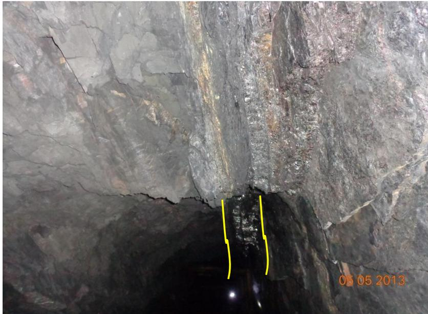
Foto 5 Manto Carito con 40 cm espesor, flanco derecho de la labor principal del nivel 0, en el tramo 210 km. Reina Cristina N 4. Foto mirando el techo.
