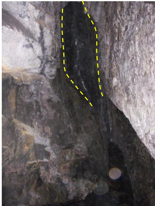
Foto 8. Manto Carito 2, de 0.50m espesor crucero 01, en el tramo 175 de la labor principal del nivel 0 de Reina Cristina 4, se observa el manto emplazado en la parte superior.
