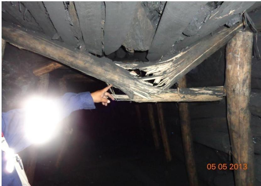
Foto 6. Sostenimiento en pésimo estado de conservación en el tramo 250 del nivel 0, en Reyna Cristina 4, el manto Carito tiene continuidad sobre el sostenimiento. Esta condición insegura de sostenimiento ocurre en todas las labores del área.
