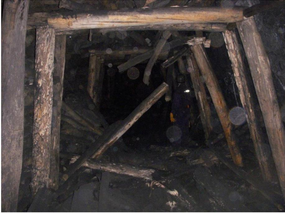
Foto 15. NIVEL 1, Reina Cristina 4, Tomado a los 24 metros del crucero 01, zona colapsada con sostenimiento en mal estado.
