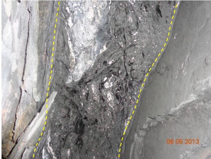
Foto 7. Manto Carito en el tramo 327 crucero X-503-E, del nivel 0 de reina Cristina, el manto continua con 40 cm. De ancho. Foto mirando el techo.
