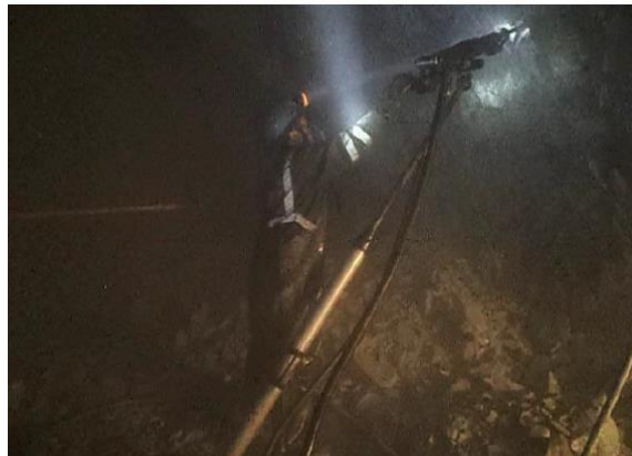
Perforación de un frente con maquina Jack Leg
