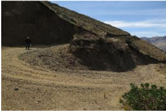
Foto N°19: Terreno prog: 25+500. La superficie de rodadura se ha deteriorado por deformación (entre 5 y 10 cm)
