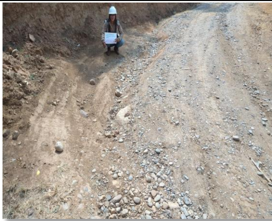
Foto N°1: Se obser el recorrido desde el inicio del tramo tomando los datos de su estado situacional
