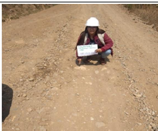
Foto N°15: Terreno prog: 16+000. La superficie de rodadura se ha deteriorado por encalaminado (mas de 10 cm)
