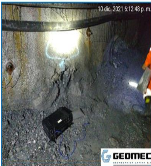
FOTO N° 7: Encendido de equipos Sismógrafos (GEOMECC) para medición de vibraciones inducidas por voladura. Rampa 8600 frente desquinche.
