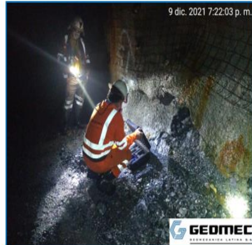
FOTO N° 6: Instalación de equipos Sismógrafos (GEOMECC) para medición de vibraciones inducidas por voladura, bajo supervisión del ING Rubén Maza. Tajo 8650 Corredor 1 Norte.
