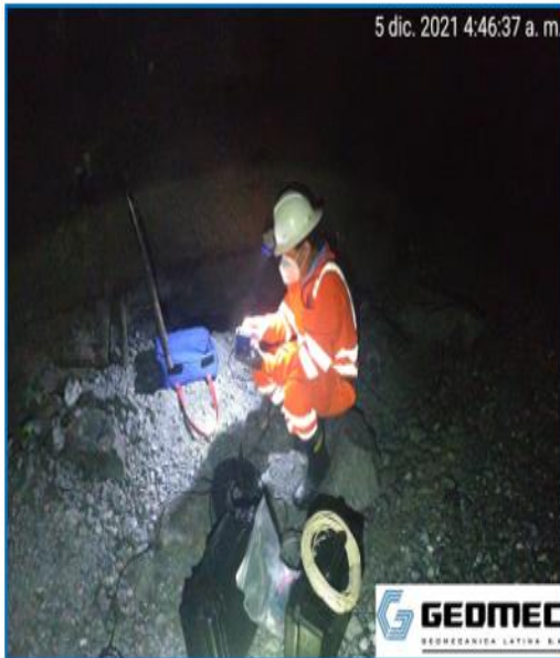
FOTO N° 1: Instalación de equipos Sismógrafos (GEOMEC) para medición de vibraciones inducidas por voladura. Tajo 8640 Corredor 1 Sur frente Breasting.
