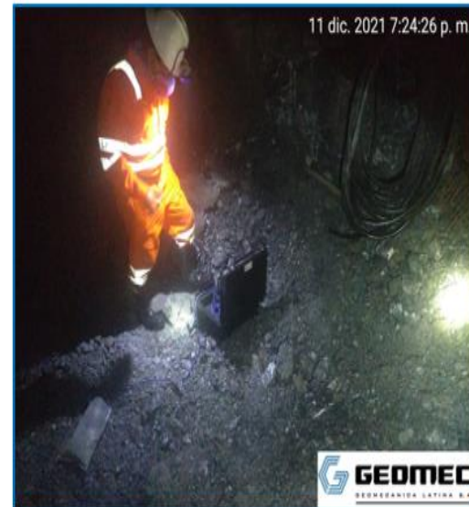
FOTO N° 8: Instalación de equipos Sismógrafos (GEOMECC) para medición de vibraciones inducidas por voladura. Tajo 8640 ventana 2 Sur frente breasting.
