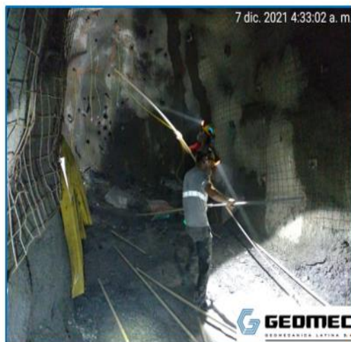
FOTO N° 3: Carguío de taladros en frente completo por personal SIMSA para monitoreo de vibraciones inducidas por voladura. Tajo 8650 Ventana 3.
