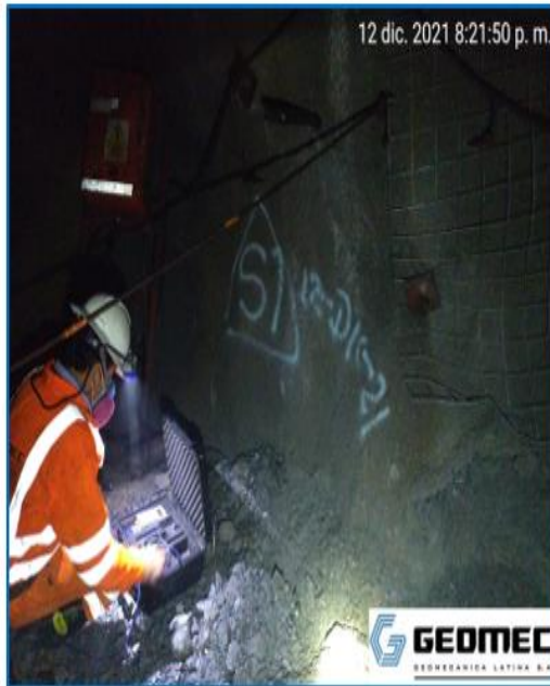
FOTO N° 9: Instalación de equipos Sismógrafos (GEO MEC) para medición de vibraciones inducidas por voladura. Cx 8586 frente completo.
