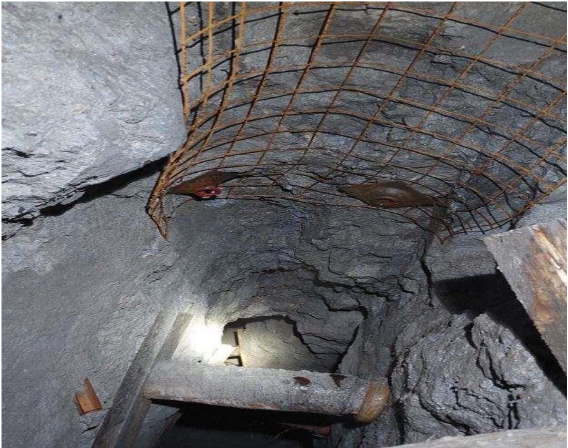
Figura 43. Sostenimiento de labores subterráneas.
