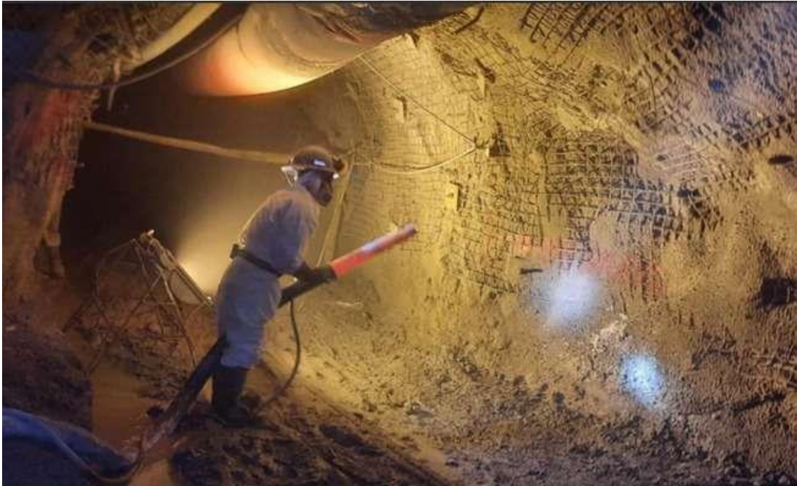
Figura 40. Trabajos de sostenimiento de labores subterráneas.
