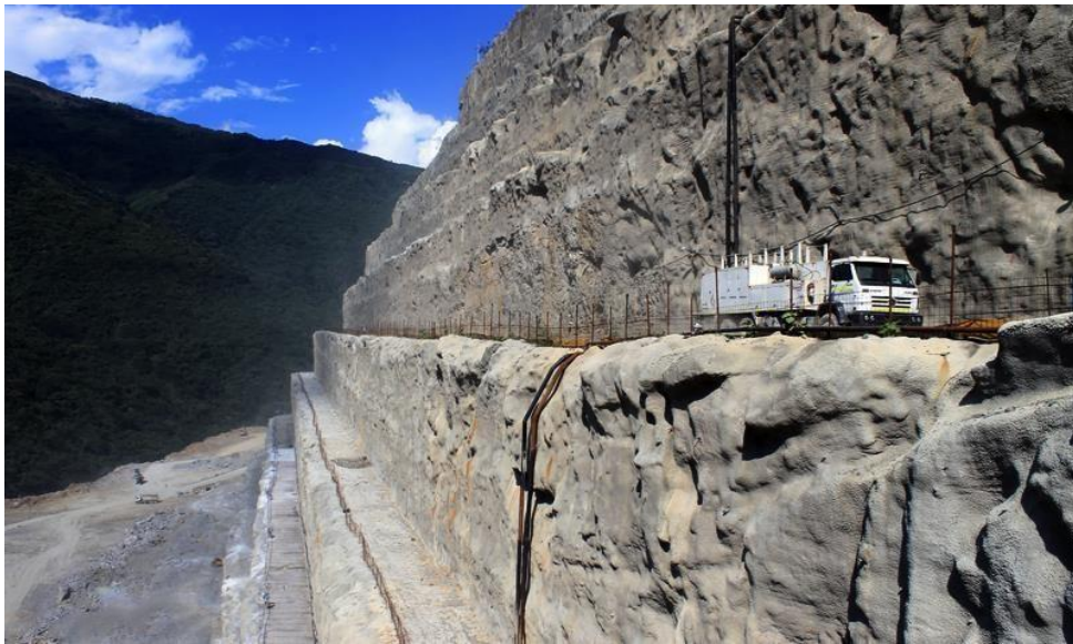
Figura 2 Taludes en rocas
