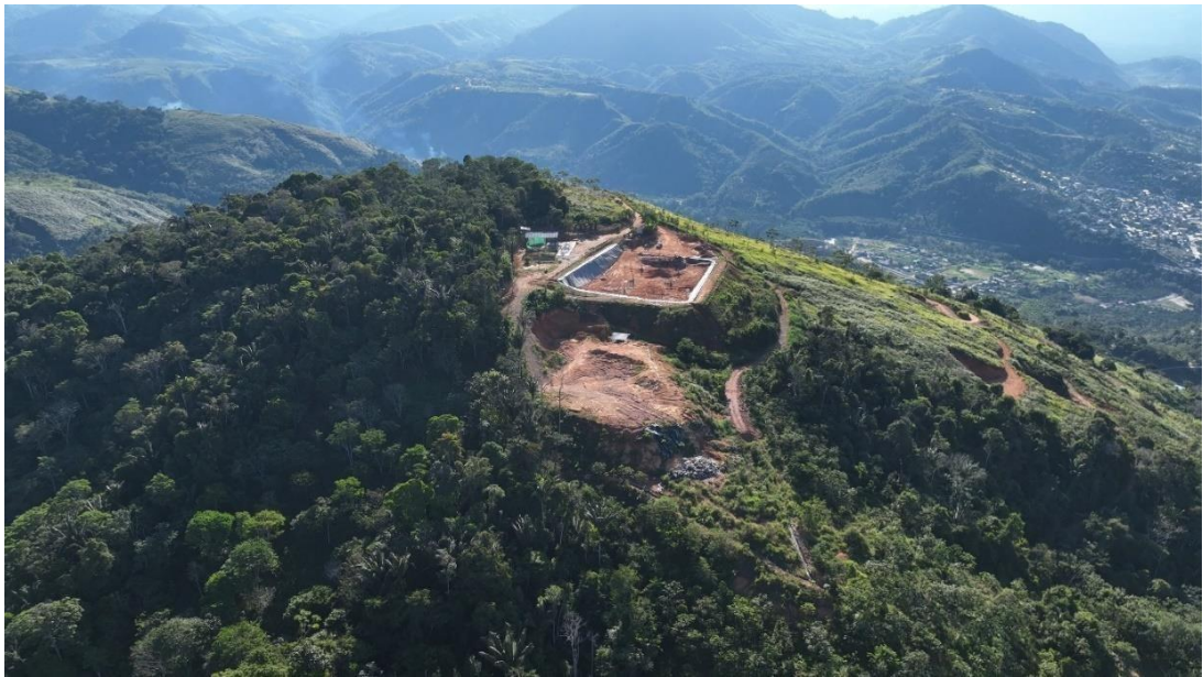
Figura 9 Vista de talud 1
