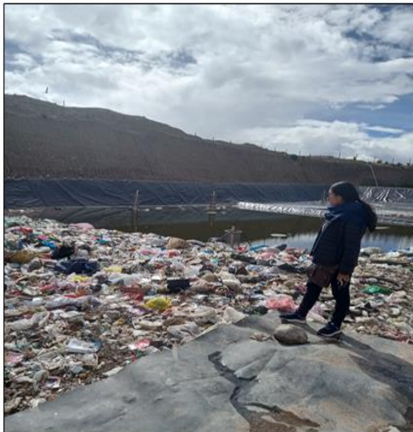
Imagen 12 Vista de las celdas transitorias con presencia de lixiviados acumulados
