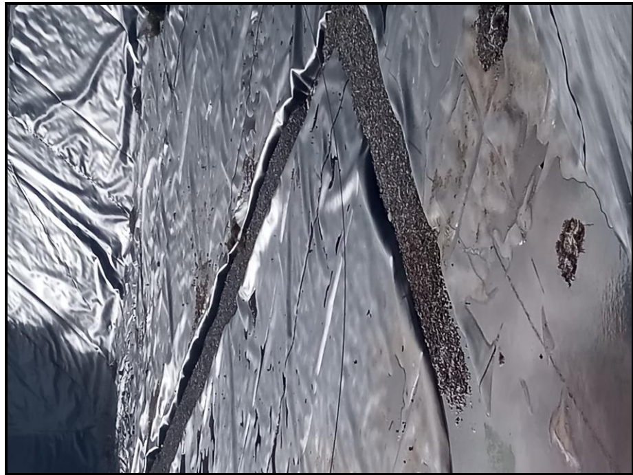
Imagen 10 Vista de la geomembrana de 2.5mm
