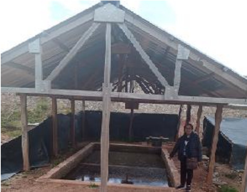
Fotografía N° 005: Vista de la infraestructura de los lixiviados debajo de las celdas transitorias
