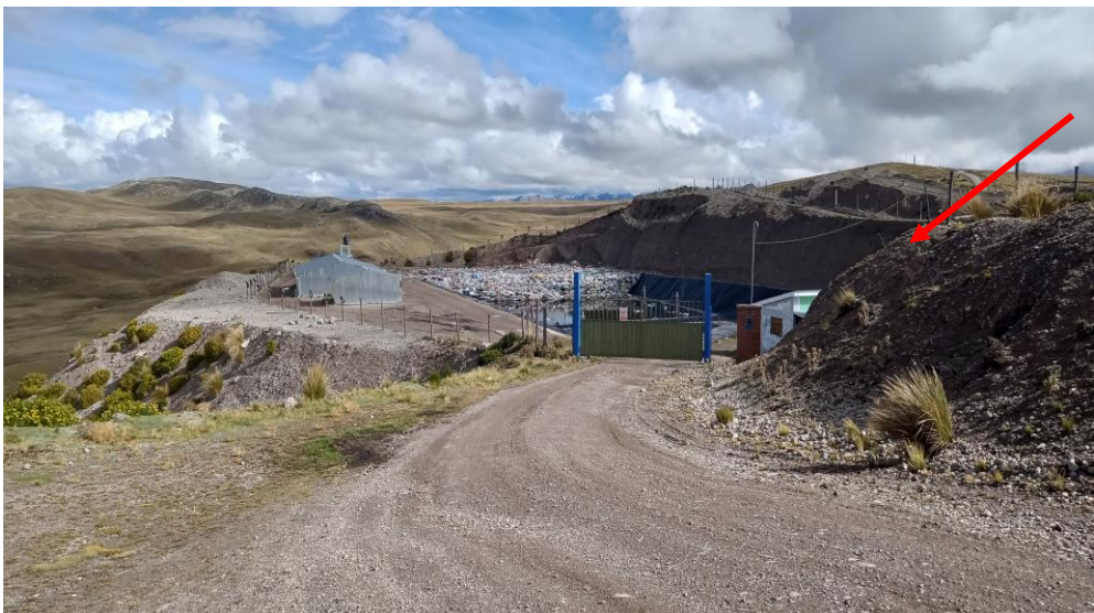
Imagen 21 Vista de canales perimétricos de agua de escorrentía
