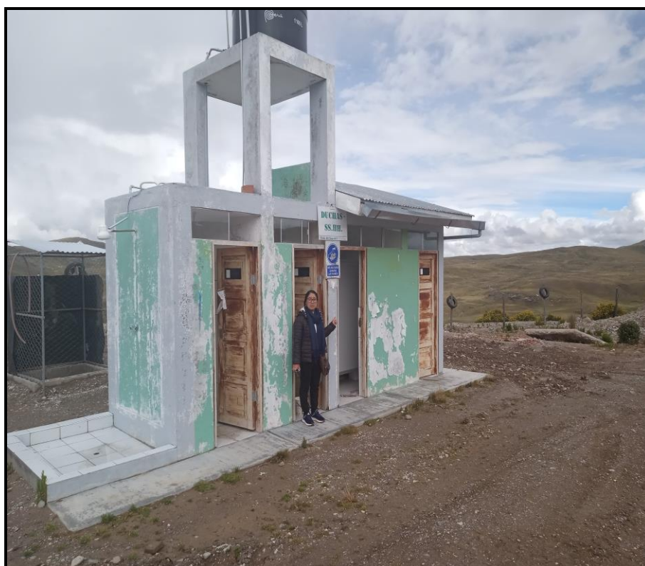
Imagen 5 Vista del servicio higiénicos
