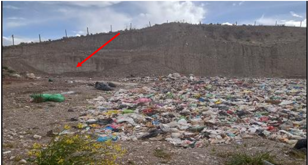
Imagen 25 Vista del espesor de tierra de 0.22 m
