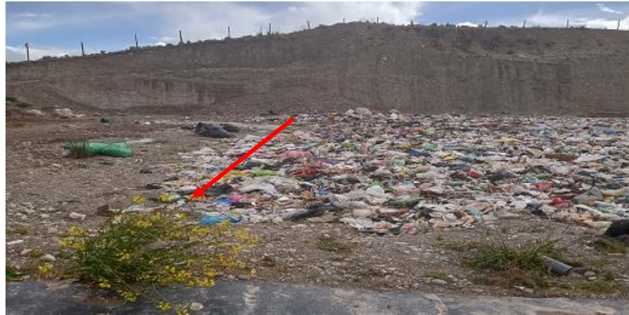
Imagen 26 Vista del espesor de tierra final 0.22 m
