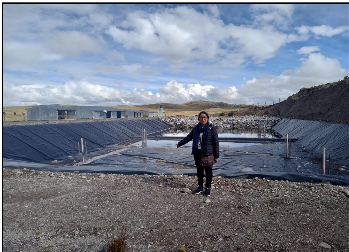
Fotografía N° 004: Vista de la trincheras en las celdas transitorias
