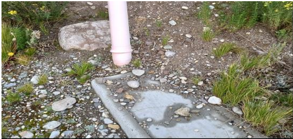
Imagen 22 Vista la evacuación de aguas de escorrentía
