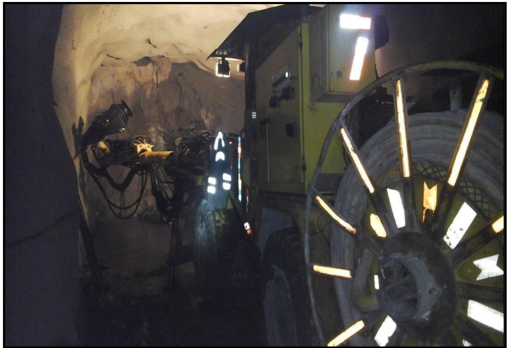
Ilustración 10. Equipo perforador frontonero en perforación.
