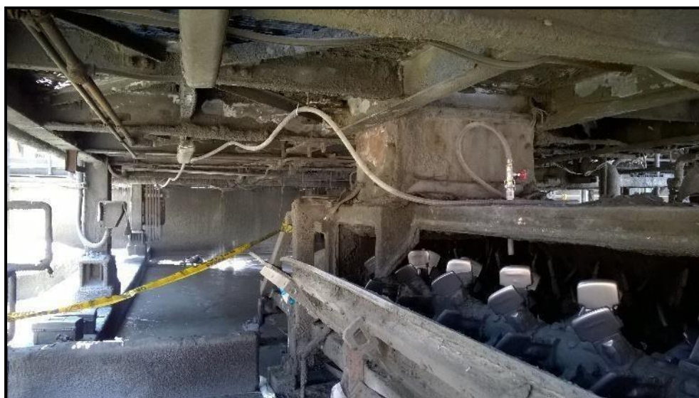
Ilustración 23. Punto de descarga de la línea de aditivo en el mezclador continuo de Planta
