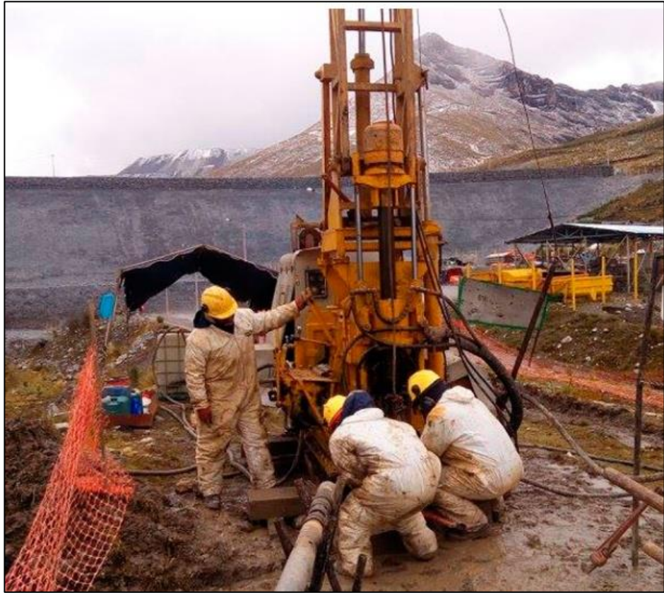
Proceso de perforación diamantina
