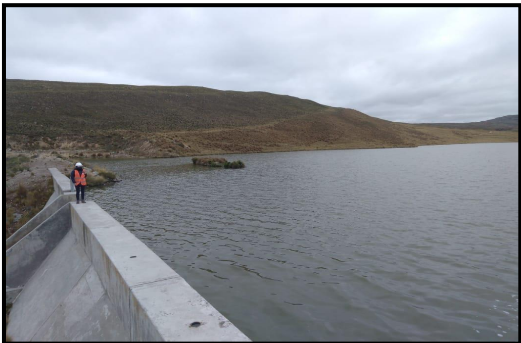
Imagen 3. Identificación del punto de captación.
