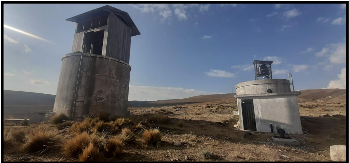
Imagen 7. Planta de Tratamiento de Agua Potable de Shelby
