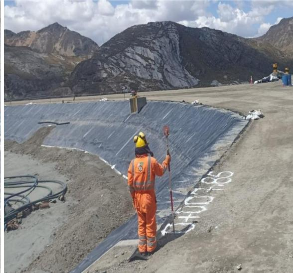
Liberación por topografía de Zanja de anclaje Capa 2 Progresivas 0+233.00 a 0+007.85,
