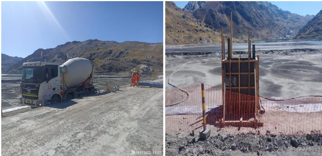
Verificación y validación de la colocación del vertido de concreto del piezómetro P1 progresiva 0+ 161.39 -0+163.32, cota inicial 4414.00 msnm, cota final 4414.50 msnm, P2 progresiva 0+ 034.50 – 0+36.00.
