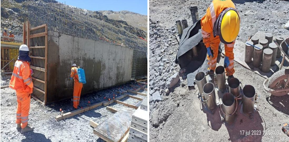
Verificación de la colocación de curador químico Antisol en muro aliviadero y elaboración de ensayos de mortero fresco.
