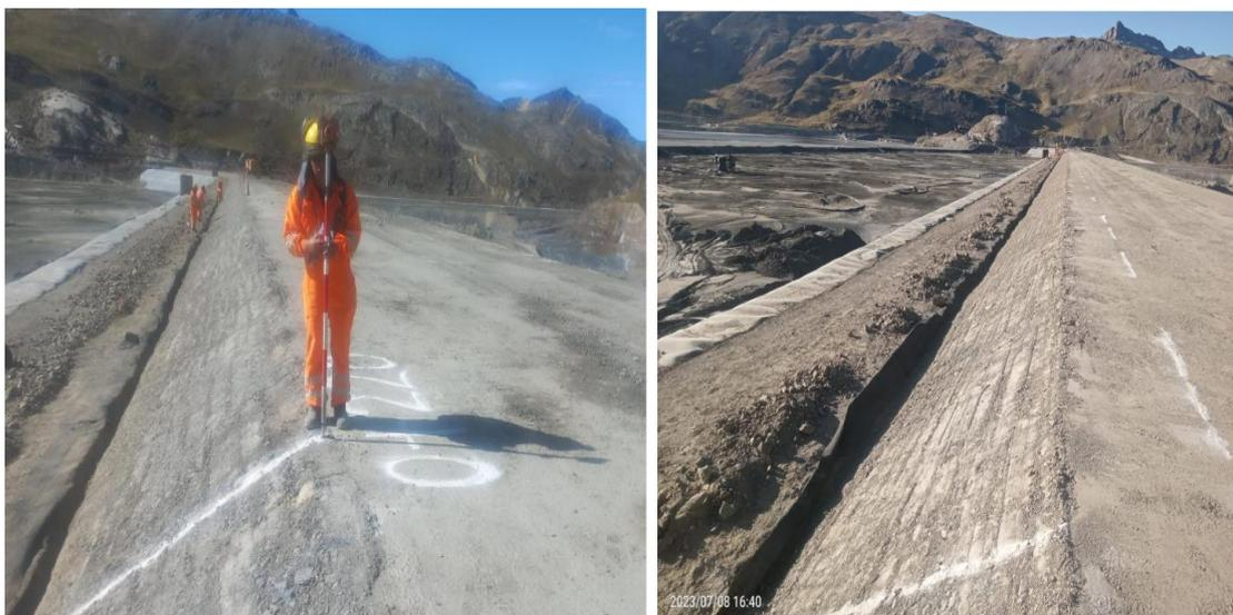
Validación de la limpieza y el adecuado proceso del perfilado del talud aguas arriba progresivas 0+220-0+479.23.
