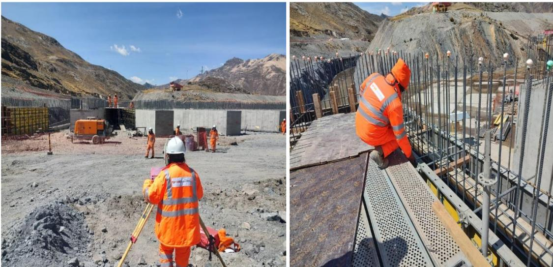
Verificación de los niveles y cotas del encofrado de los Muros 31, 32 y 33, progresivas 0+074.08 – 0+096.48 a una altura de 2.5m.
