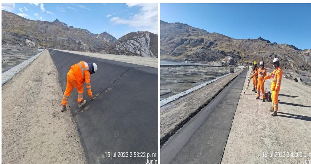
Verificación de las uniones de geotextil , además del material Tipo I existente para continuar con el recremento sobre la misma.
