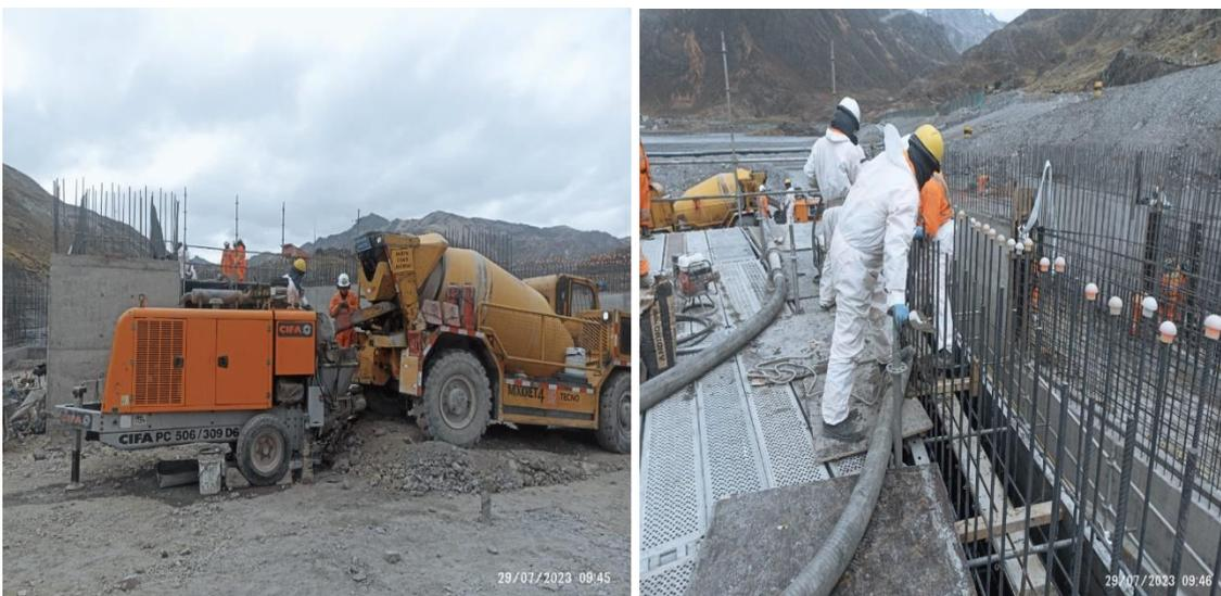
Verificación del vertido de concreto de los Muros 31, 32 y 33, progresivas 0+074.08 – 0+096.48 a una altura de 2.50 m, un total de 41 m<sup>3</sup>.
