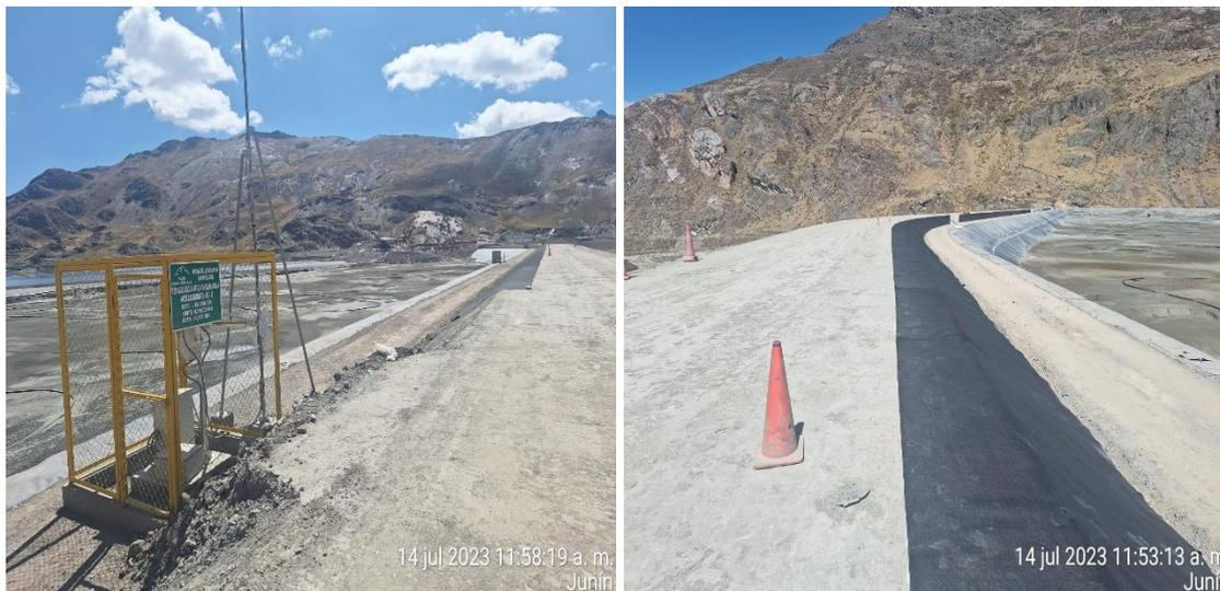
Verificación de la colocación de geotextil 800 g/m<sup>2</sup>, además se identifica el desmontaje del acelerógrafo como restricción futura en la colocación de material Tipo I.
