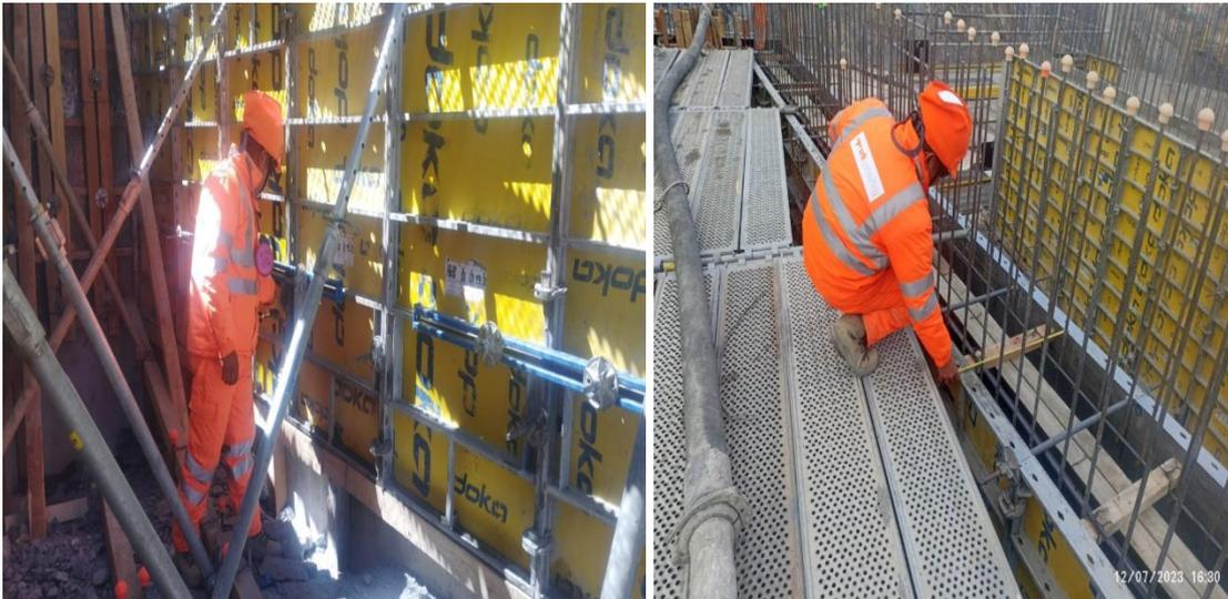
Validación del encofrado del Muro 19, 20 y 21, entre las progresivas 0+205.03 @ 0+228.51 a una altura de 2.5m.
