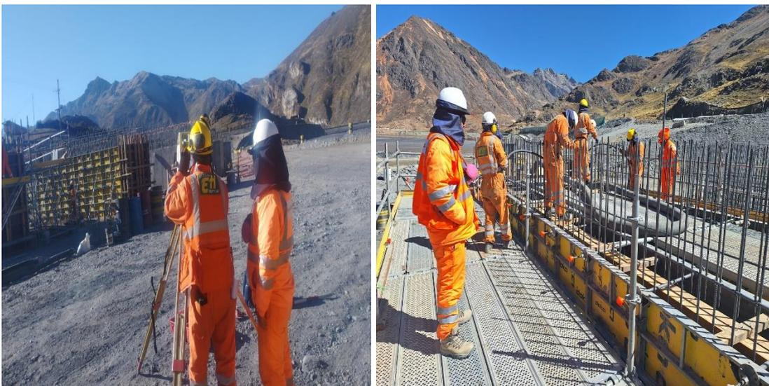
Verificación del alineamiento y verticalidad del encofrado, así mismo la colocación y vibrado de mortero.
