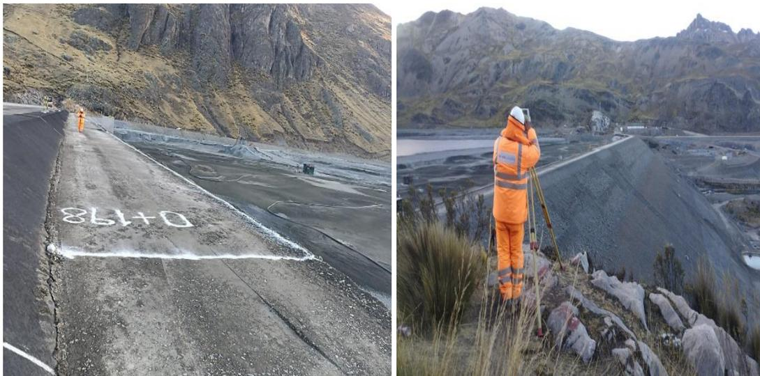
Inspección de la conformación de plataforma Capa 1, material Tipo I, entre las progresivas 0+051 @ 0+198, cota 4413.25. Aún pendiente el ensayo de densidad para liberación de capa.
