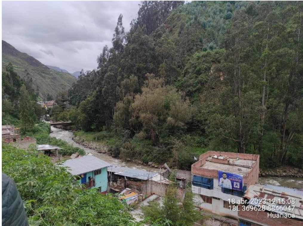
Fotografía 05: Vista del puente y lado del río que se trabajó (fuente: propia)
