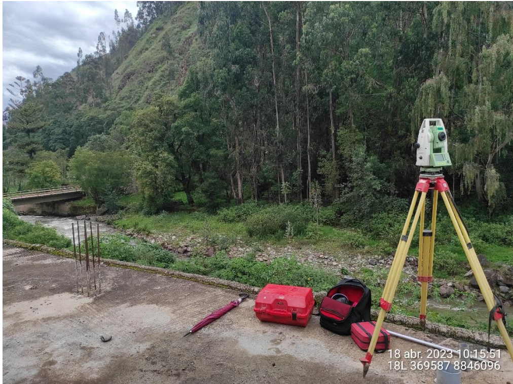
Ilustración 8 Vista de equipo Estación Total trabajando en la zona (fuente: propia)
