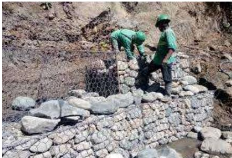
Figura N° 18: Gaviones con relleno de piedra
