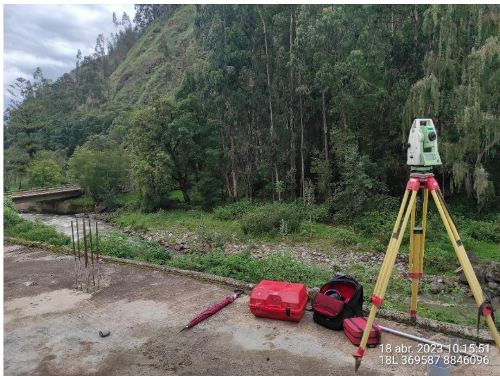
Fotografía 02: Vista de equipo Estación Total trabajando en la zona (fuente: propia)
