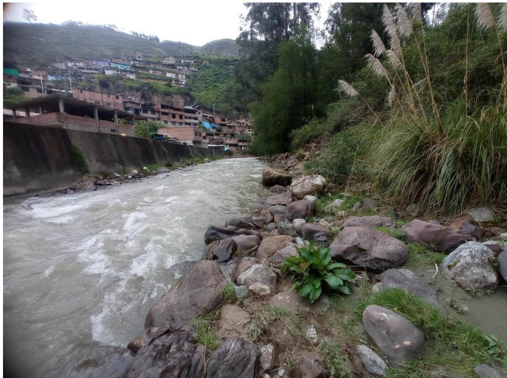
Ilustración 13 Vista del cauce y borde del río Huallaga (fuente: propia)
