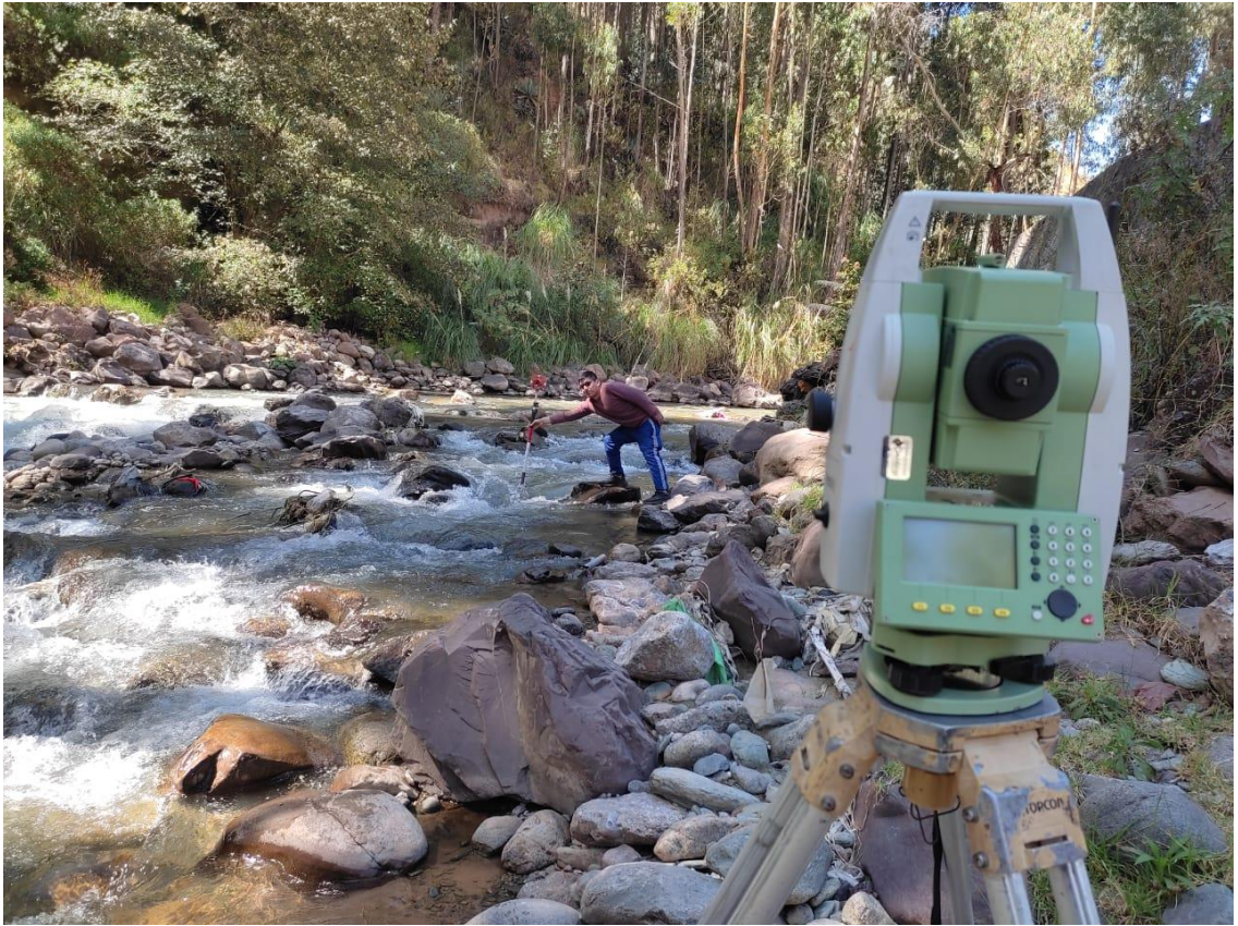
Fotografía 10: Observando el nivel de agua del rio Huallaga (fuente: propia)
