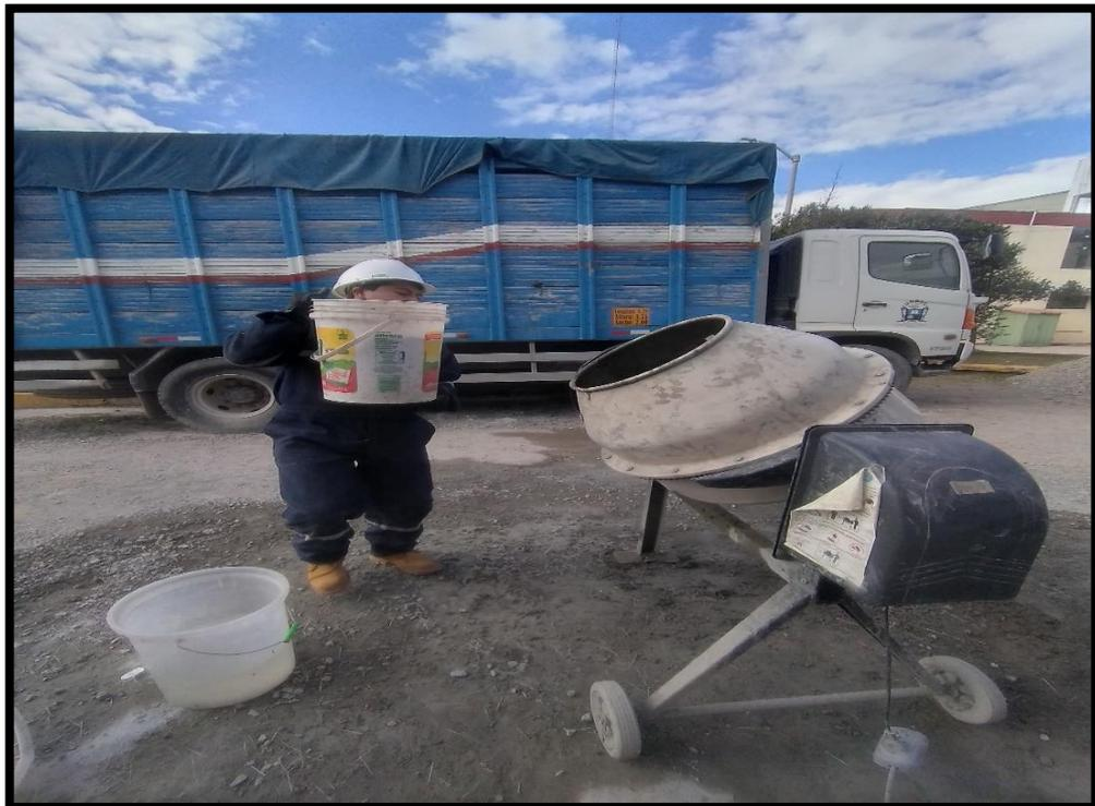
**Fotografía N°16.-** Se aprecia el vertido del cemento en el trompo mezclador.
