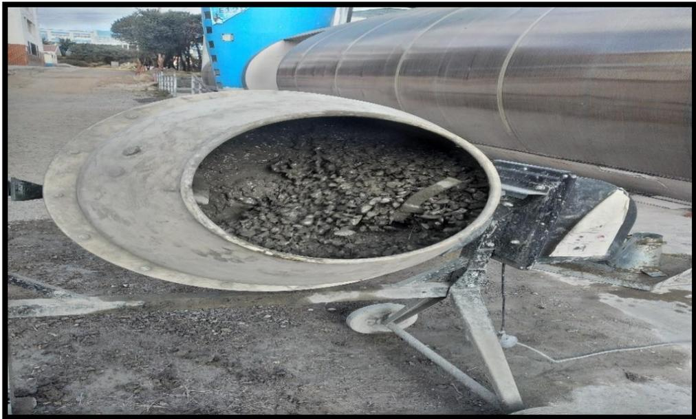
**Fotografía N°20.-** Se aprecia el proceso de mezclado del concreto hasta que todos los componentes queden en un conglomerado homogéneo.
