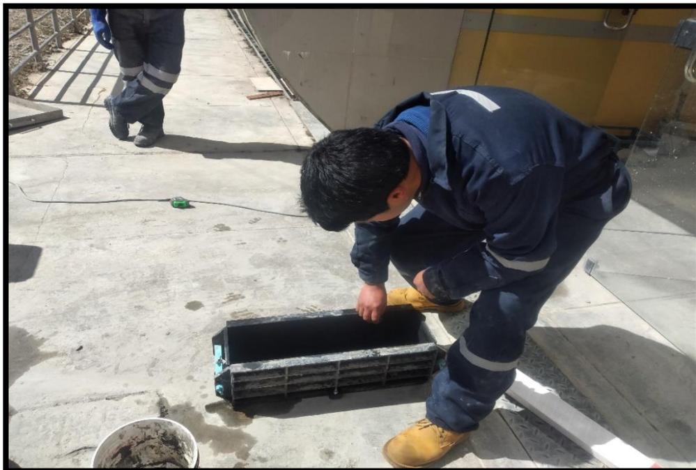
**Fotografía N°14.-** El colocado de un petróleo es importante para que cuando se realicé el desencofrado no se adhiera el concreto al molde.
