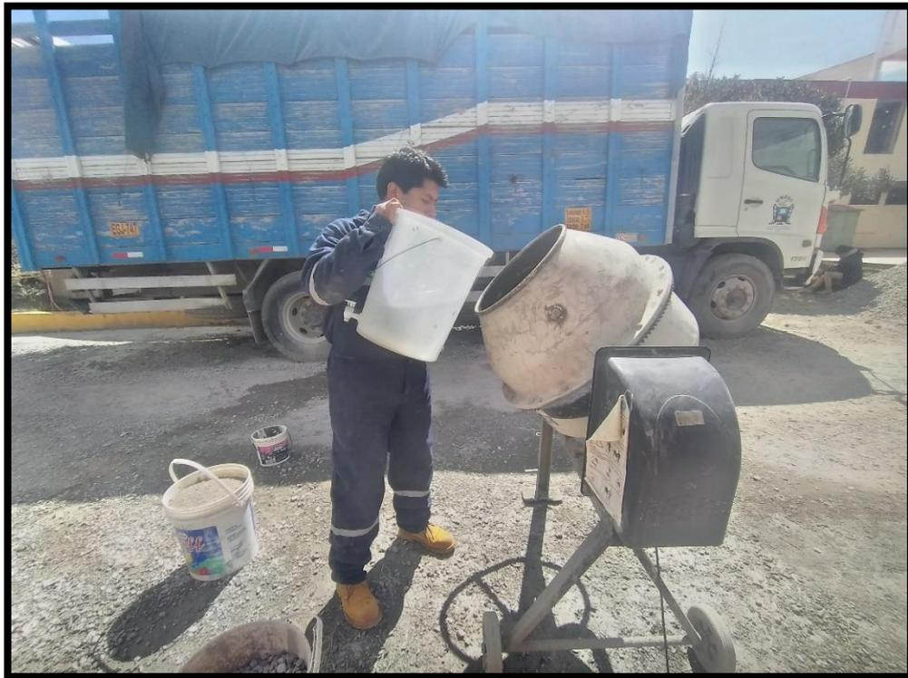
**Fotografía N°15.-** Se aprecia el inicio del mezclado del concreto añadiendo inicialmente un 20% del volumen de agua.
