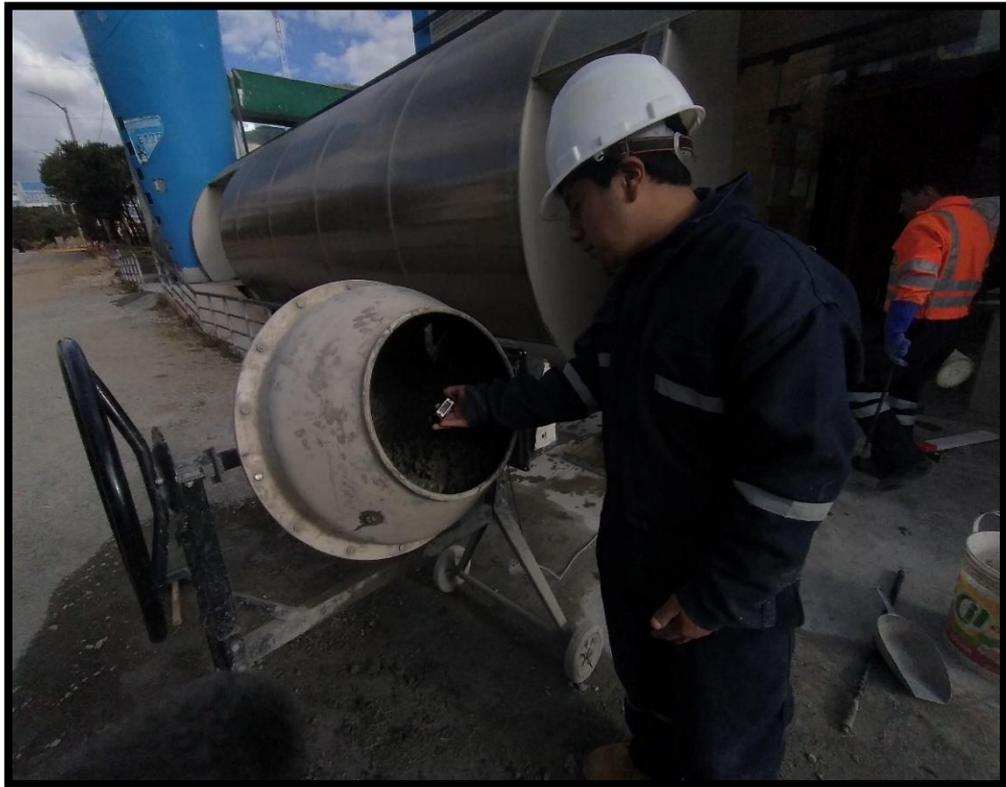
**Fotografía N°21.-** Se aprecia el control de la temperatura de la mezcla.
