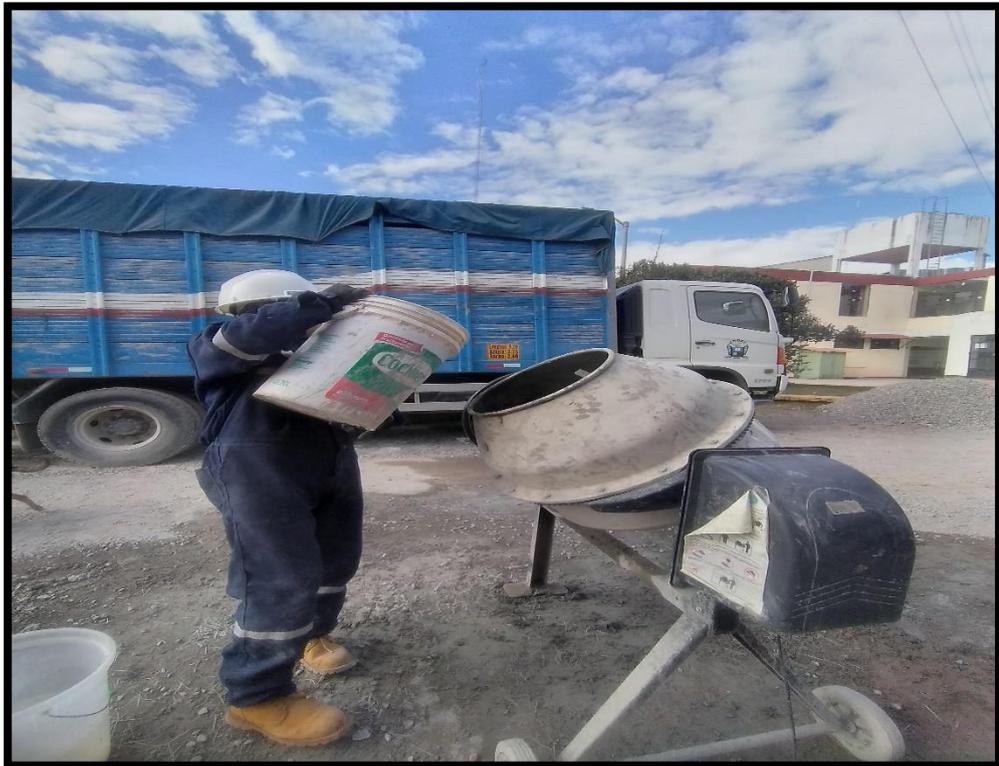
**Fotografía N°18.-** Se aprecia el vertido del agregado grueso en el trompo mezclador
