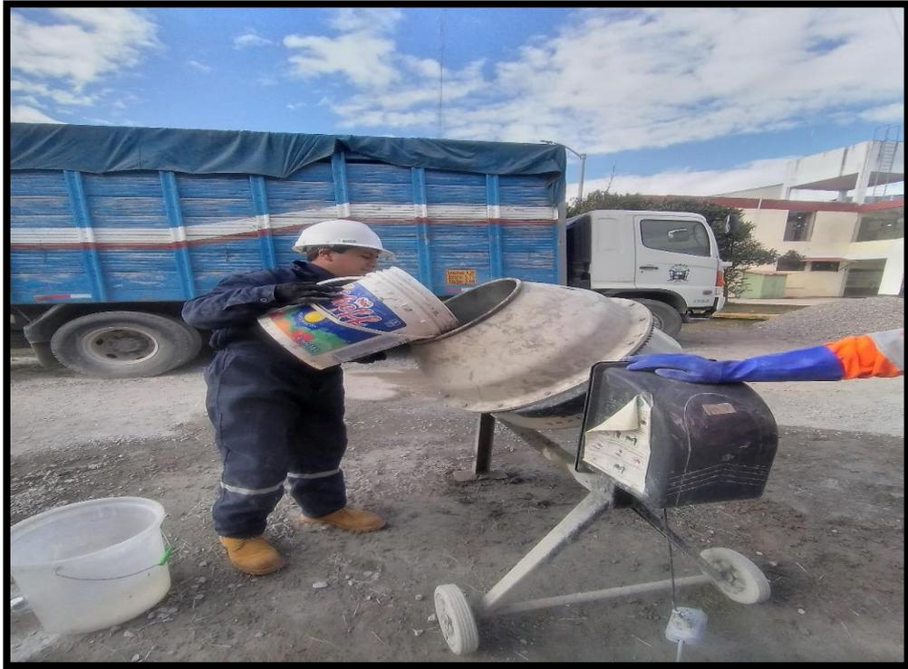
**Fotografía N°17.-** Se aprecia el vertido del agregado fino en el trompo mezclador.
