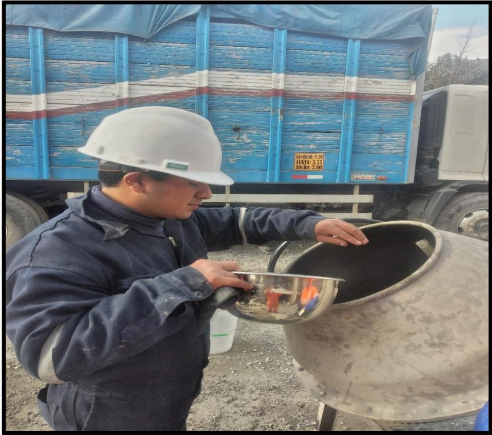
**Fotografía N°19.-** Se aprecia el vertido de las fibras de acero en el trompo mezclador.
