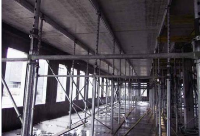
Gráfico 12 Cimbrado de paneles
