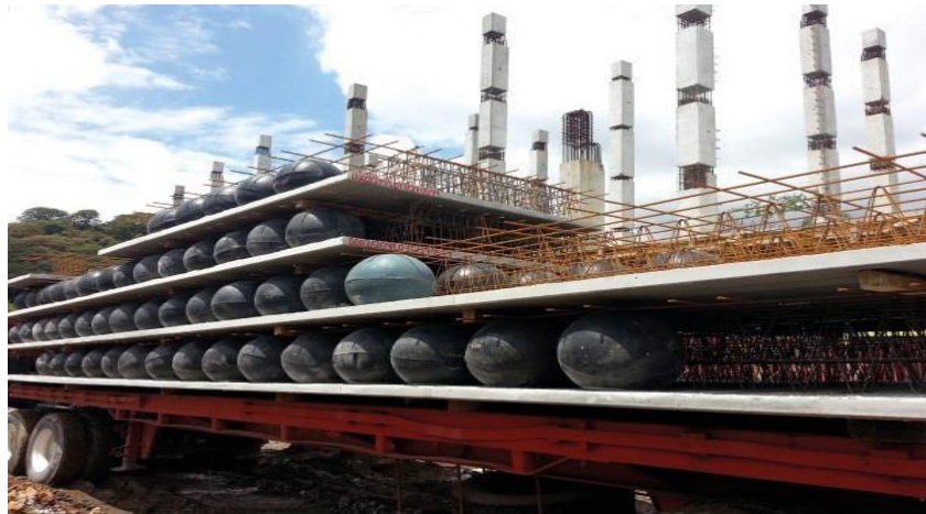
Gráfico 9 Transportación de los paneles
