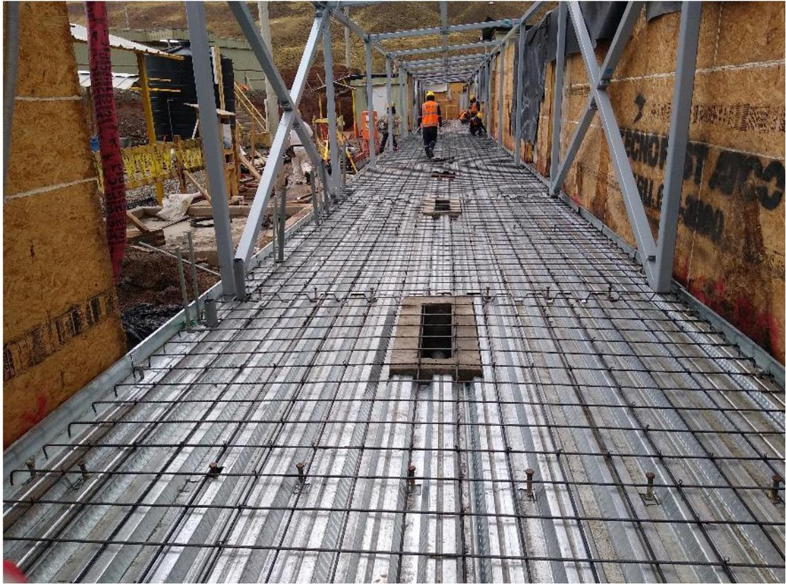
*Ilustración 37 Armado de acero de temperatura para placa colaborante - Fuente: propia*
