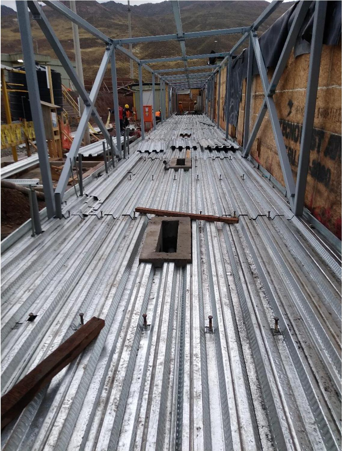
*Ilustración 36 Distribución de placa colaborante y conectores - Fuente: propia*
