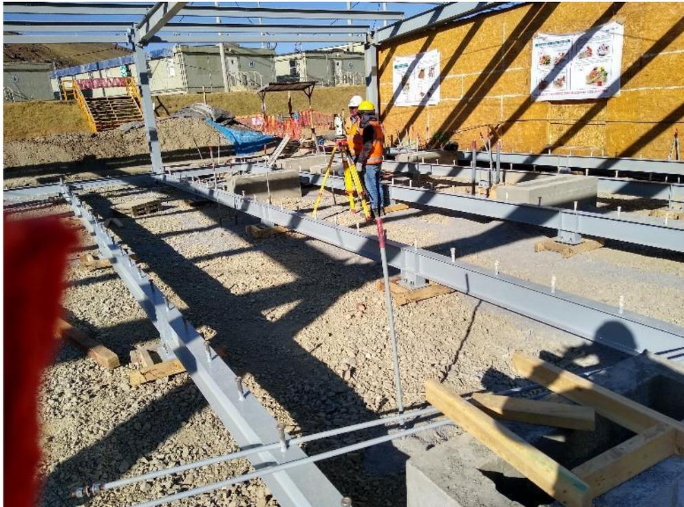
*Ilustración 35 Armado de estructura para placa colaborante - Fuente: propia*
