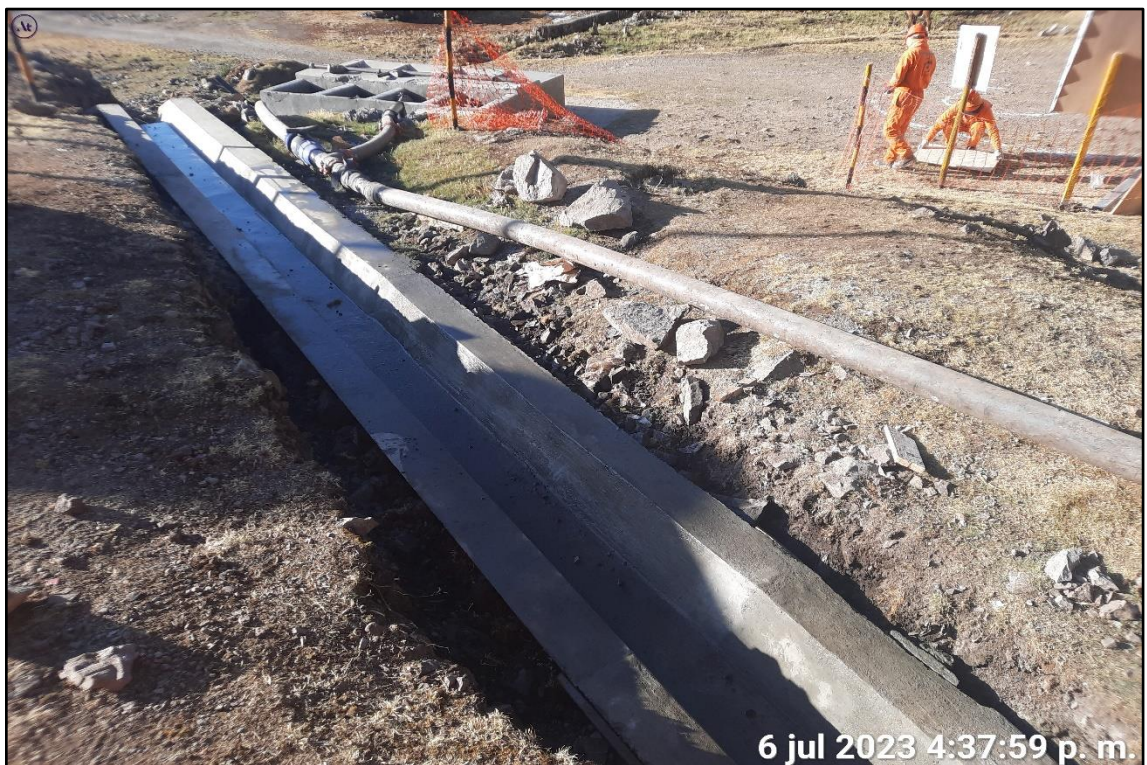
Anexo 41: Registro fotográfico de trabajos finalizados en canal de derivación.
