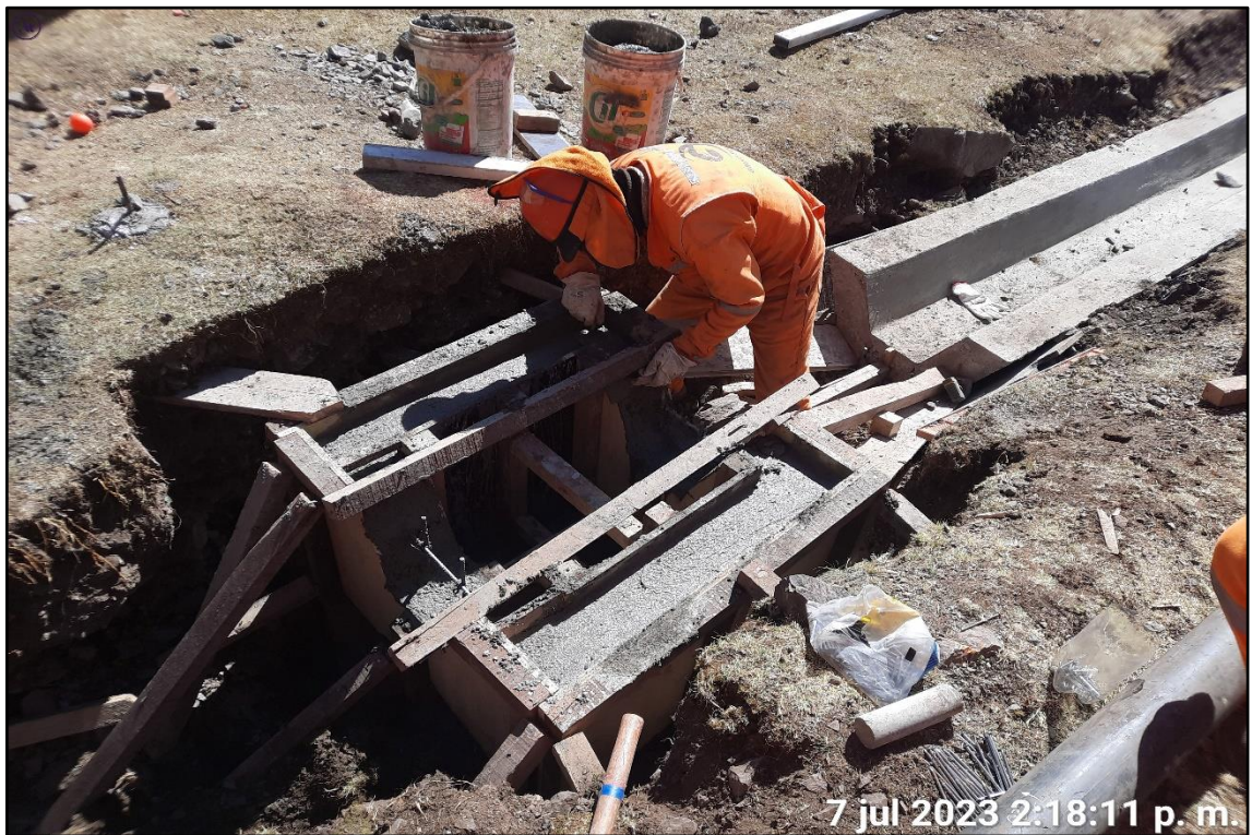
Anexo 40: Registro fotográfico de trabajos de encofrado de caja de paso.
