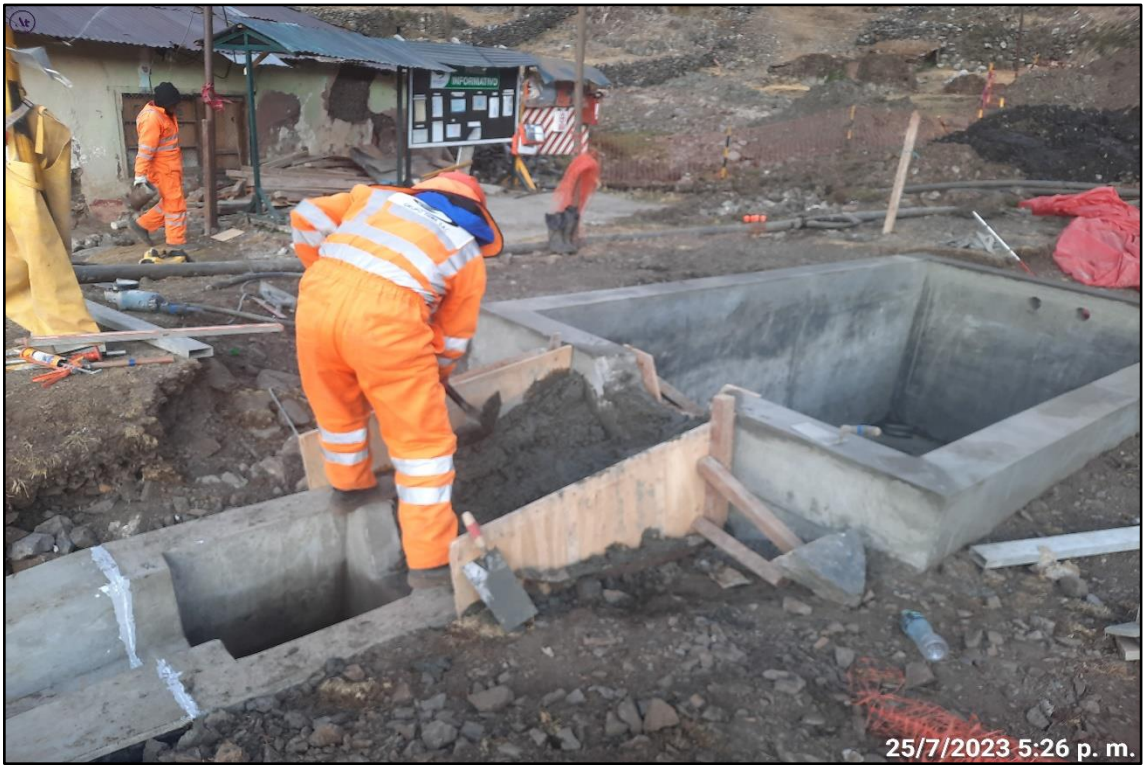
Anexo 44: Registro fotográfico de trabajos de vaciado de concreto en canal de derivación.
