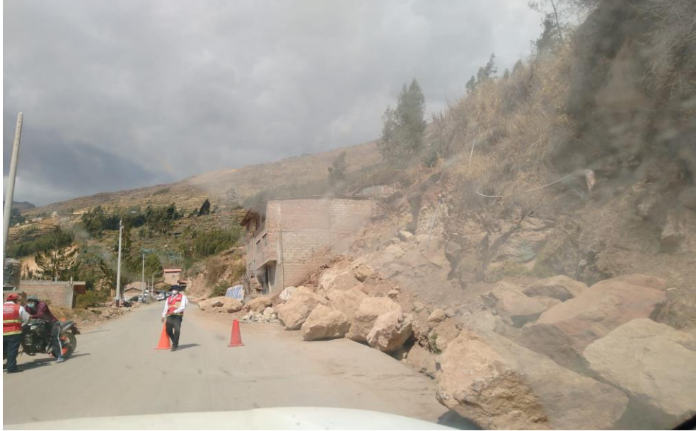
Ilustración 4: Presencia de derrumbes en laderas – Afectan el Pavimento Flexible (Fuente: Propio)
