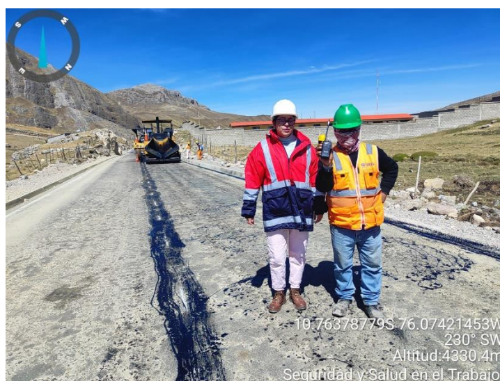
Ilustración 13: Colocación de imprimación en la carretera Ninacaca - Huachon, dando del cumplimiento de las medidas de mitigación (Fuente: CVNH)
