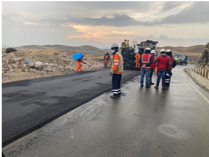
Ilustración 12: Colocación de recapeo km 2+040 (fuente: Propio)
