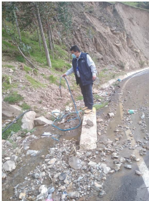
Ilustración 11: Verificación de Presencia de alcantarillas y cauces saturados (Fuente: Propio)
