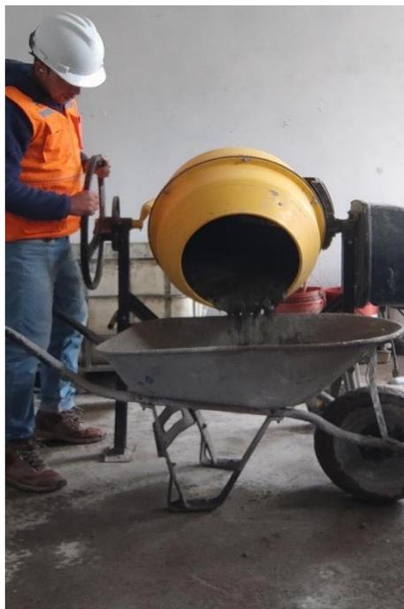
**IMAGEN 12.** Vertido de la mezcla para poder realizar los ensayos correspondientes.
