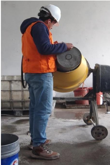
**IMAGEN 08.** Adición de agregado fino a la mezcladora de concreto.
