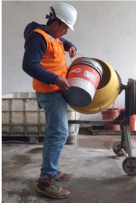
**IMAGEN 10.** Adición de cemento a la mezcladora de concreto.
