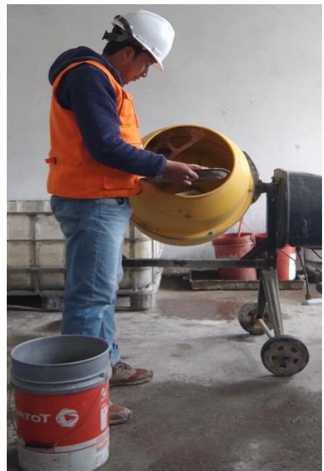
**IMAGEN 09.** Adición de arenisca cuarzosa a la mezcladora de concreto.
