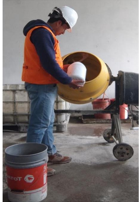
**IMAGEN 07.** Adición de agua a la mezcladora de concreto.
