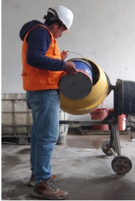
**IMAGEN 06.** Adición de agregado grueso a la mezcladora de concreto.
