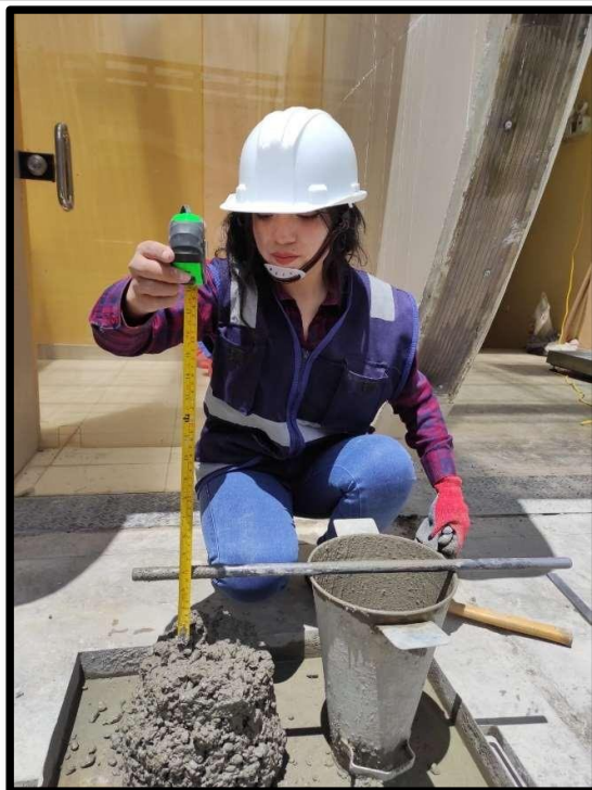
Figura 2: Obtención de la prueba de asentamiento
