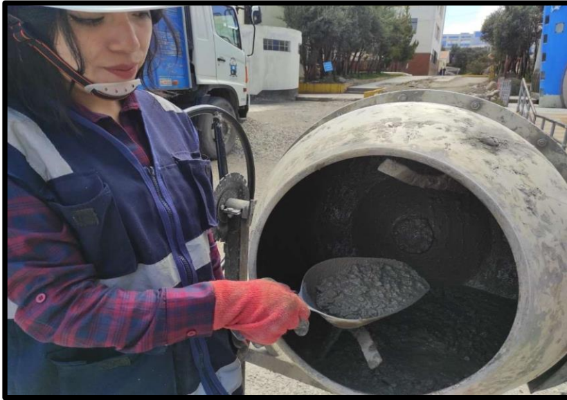
Figura 1: Obtención del concreto, según el diseño de mezcla
