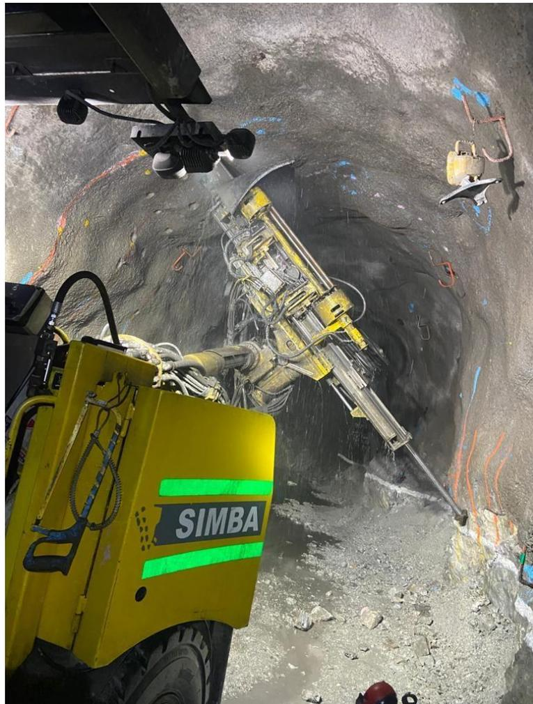
*Figura 50.* NV 4090 2T 1S PISO N°03 INTEGRACION DE (VCR, SLOT,CHIMENEA)
