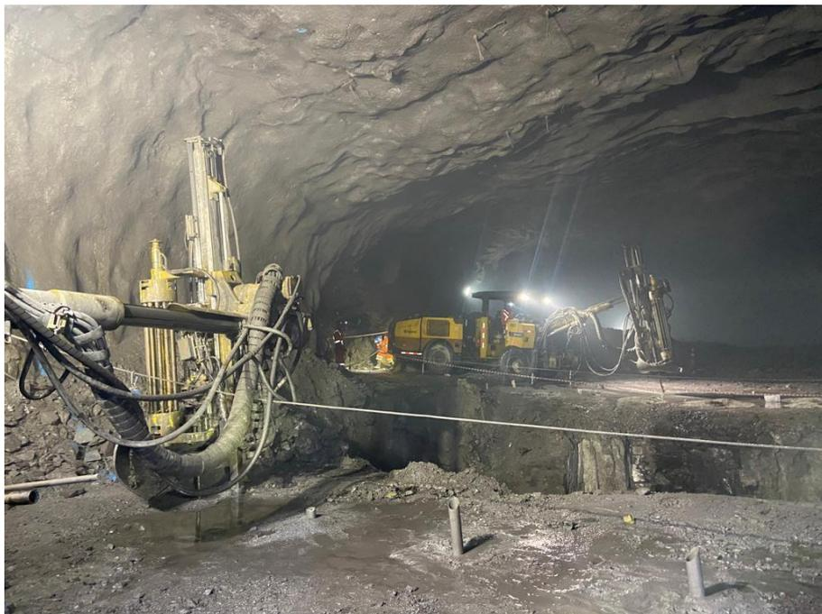
Figura 48. NV 4020 1N PISO N°02 Perforación de taladros(-) Bancada de 10mts.
