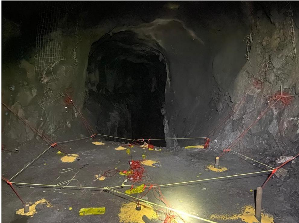
*Figura 57.* NV 4510 1N PISO N° 02 CARGUIO CON ANFO DE 03 FILAS DE TALADROS DE PRODUCCION.
