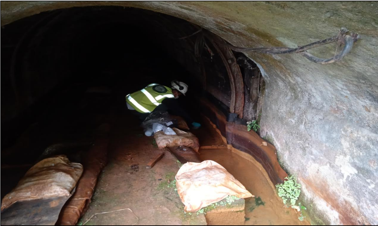
Fotografía N° 004: Vista del túnel Pucara en interior
