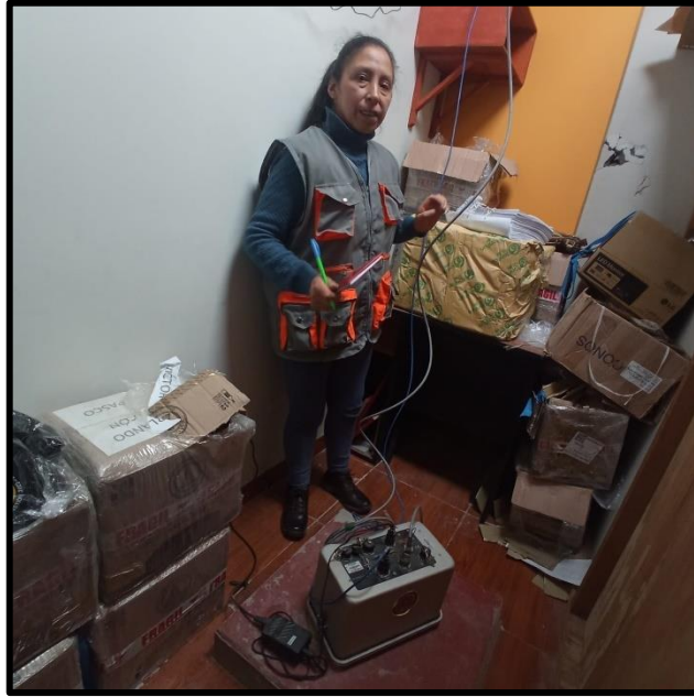
Fotografía N°01: Se verifico que el sistema estuvo un tiempo inactivo y necesita ser calibrado actualmente
