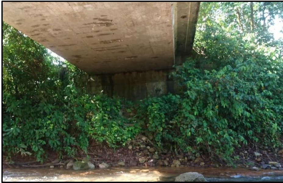
Figura 46. Estribo Derecho del Puente Nochoz
