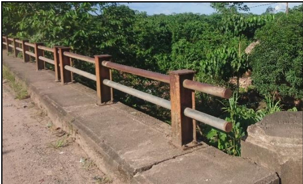
Figura 49. Barandas Metálicas al Borde del Puente Nochoz
