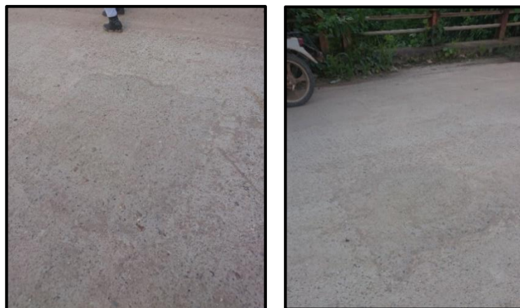
Figura 43. Resanes de la losa del puente con concreto
