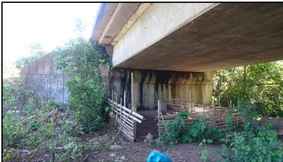
Figura 45. Estribo Izquierdo del Puente Nochoz
