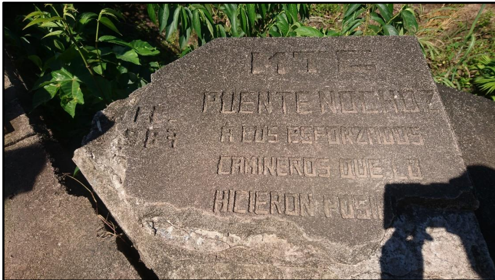
Figura 41. Placa del Puente Nochoz con la fecha de construcción del Puente
