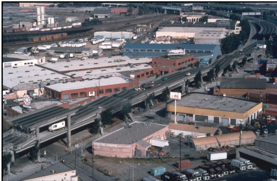
Figura 1. Colapso del Vía Ducto Cypress en el Sismo de Loma Prieta 1989. (Obtenida de: https://www.nationalgeographic.org/thisday/oct17/loma-prieta-earthquake/family/ )
