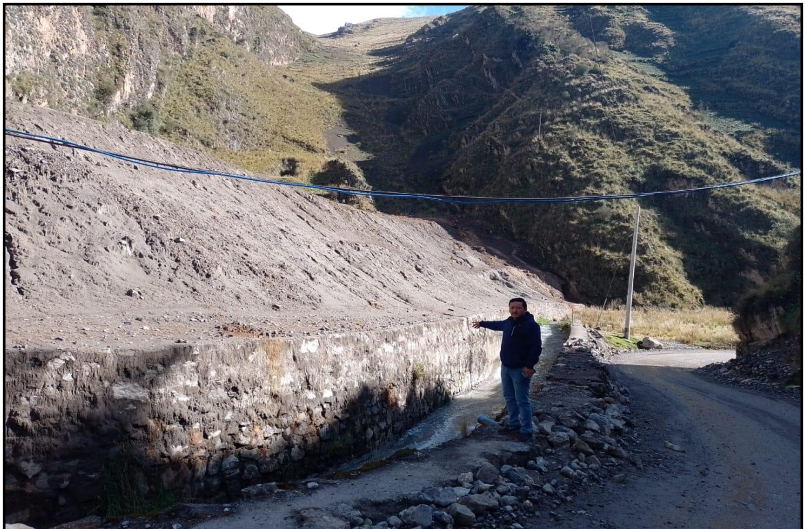
Anexo 5. Muro de protección
