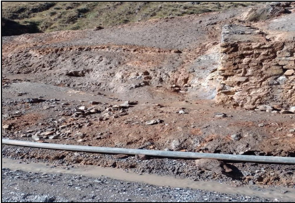
Anexo 2. Relave con presencia de desmonte de mina totalmente sin protección
