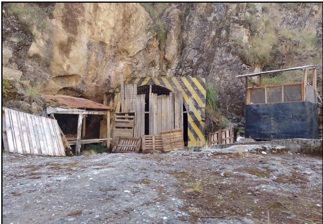
Figura 10. Imagen del Componente de la Bocamina en San Miguel
