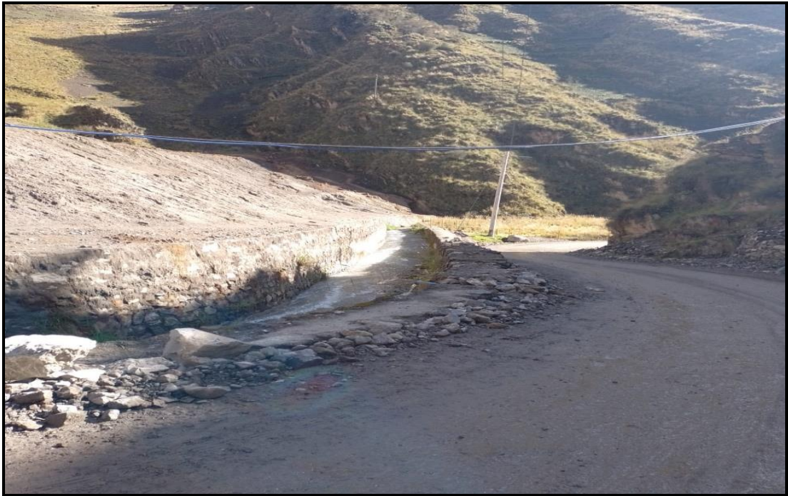
Anexo 6. Carretera de la vista de la relavera
