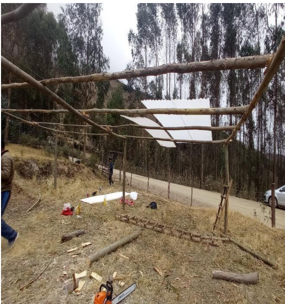
Fotografía 3: Construcción del invernadero en el lugar denominado
