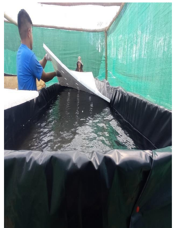
Fotografía 12: Colocación del Tecnopor en las bandejas
