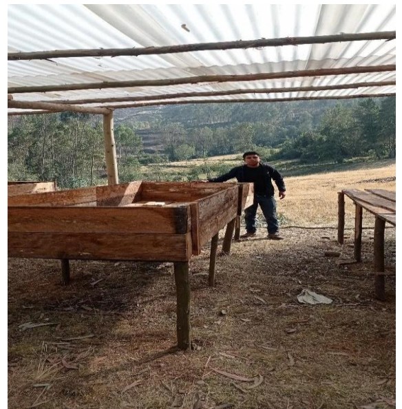
Fotografía 4: Construcción de las bandejas de 3.30 m x 1.20 m x 0.40 m (1.20 m. de altura desde el piso.)
