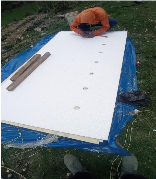
Fotografía 9: Orificios en el Tecnopor de 4 cm de diámetro
