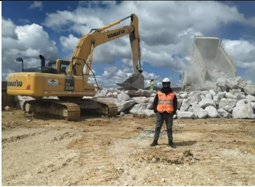
Imagen N°13: Inspección del procedimiento constructivo del pedraplén km 77+090 al km 77+500.
