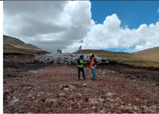
Imagen N°05: Chequeo topográfico de niveles de pedraplén en el km 92+520 al km 92+680.
