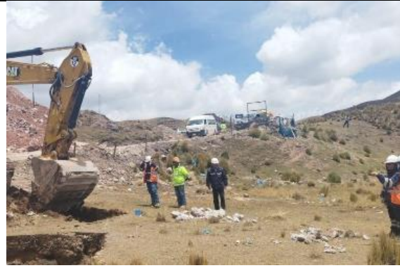
Imagen N°02: Monitoreo del terreno de fundación para la construcción del pedraplén km 93+710 al km 94+750.
