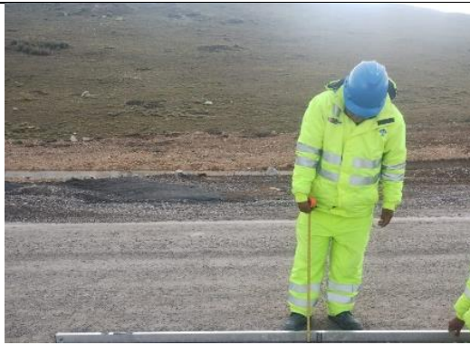
Imagen N°15: Medición de lisura de la base sobre el sector de pedraplén del km 64+110 al km 64+310.
