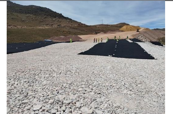
Imagen N°02: Monitoreo del terreno de fundación para la construcción del pedraplén km 93+710 al km 94+750.
