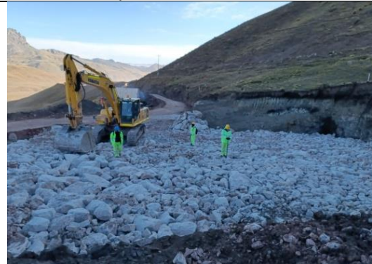
Imagen N°01: Inspección del procedimiento constructivo del pedraplén km 88+780 al km 88+920 en conjunto con Provias Nacional.
